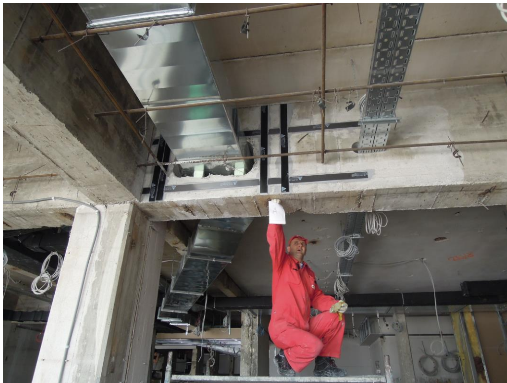
Konstrukcije Hotela Jama v Postojni
