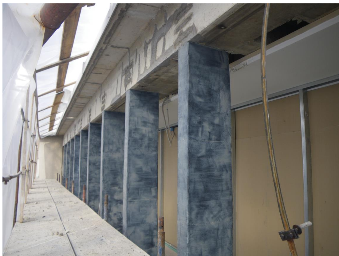
Upravna stavba SIJ, Ljubljana
