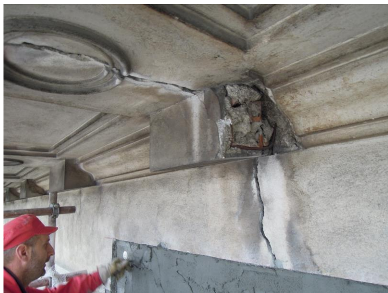
SANACIJA DILATACIJ NA FASADAH EKONOMSKE ŠOLE, LJUBLJANA
