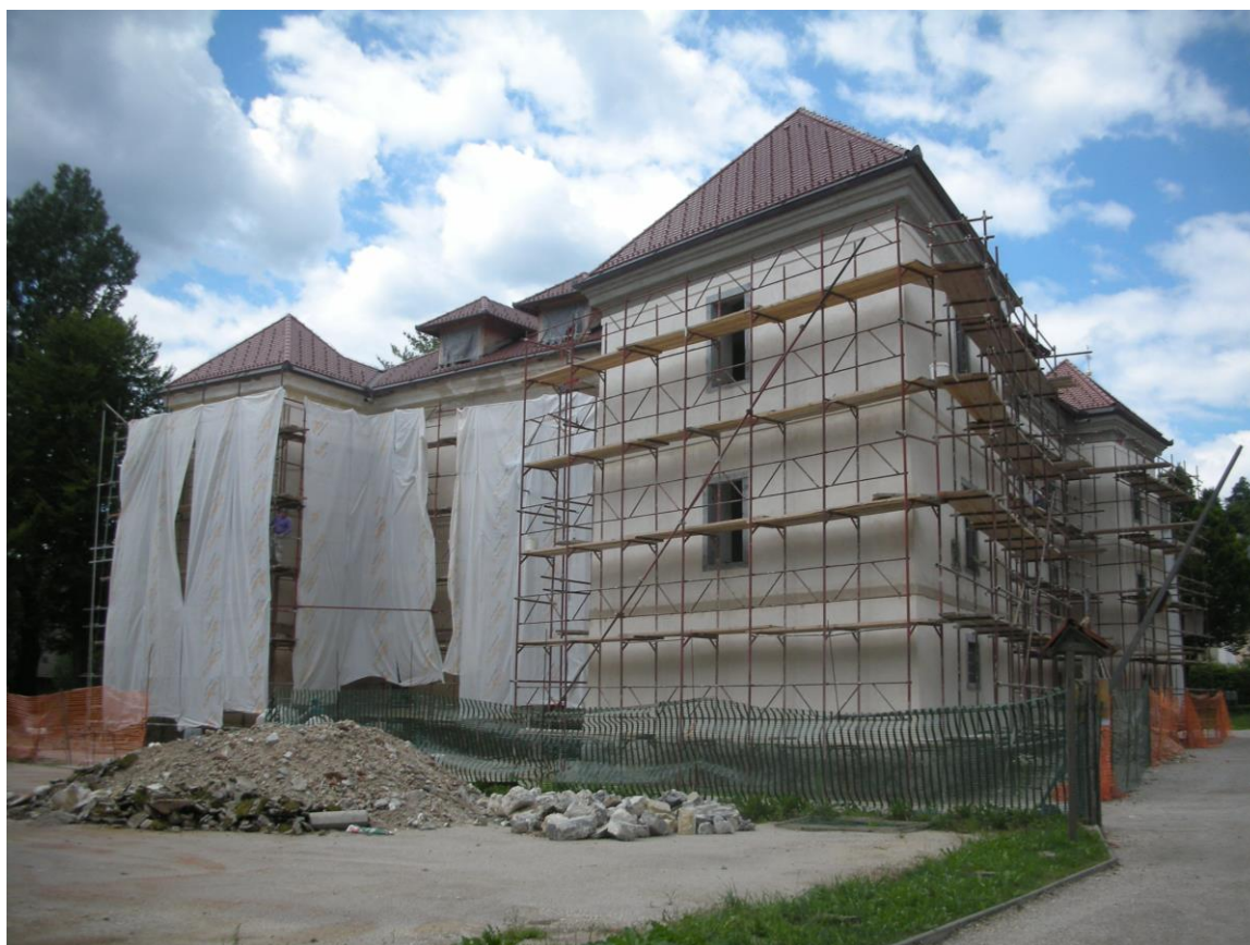
UTRDITEV ZIDOVJA GRADU, LOGATEC
