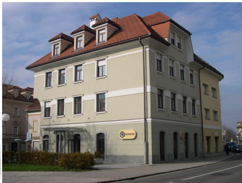
SANACIJA MESTNE KAVARNE, KOČEVJE
