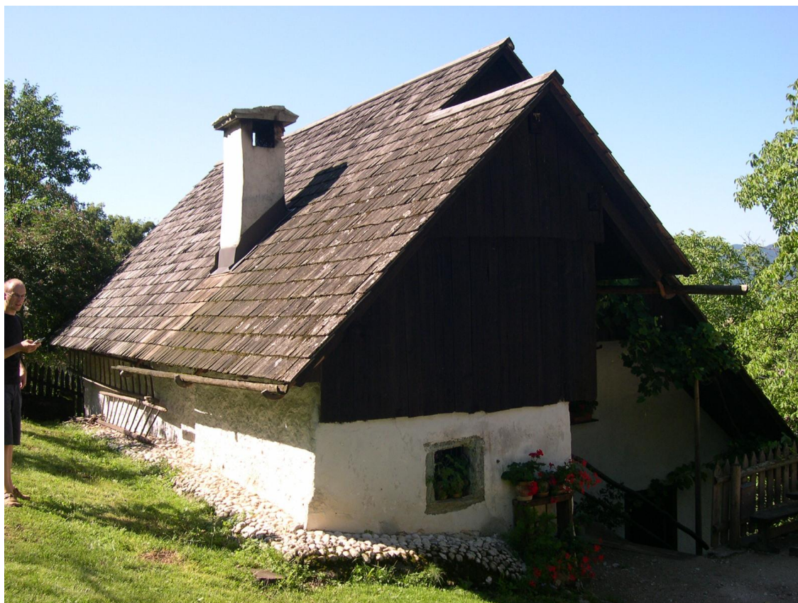
SANACIJA ROJSTNE HIŠE F.S.FINŽGARJA, DOSLOVČE
