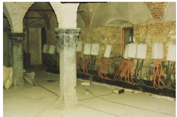
UTRDITEV ZIDOV IN SANACIJA VLAGE, GRAD BISTRA
