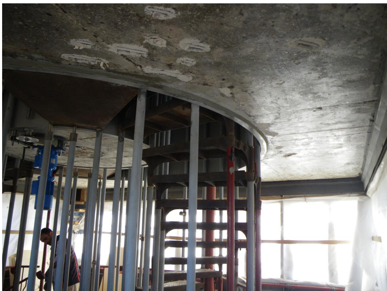
SANACIJA NOSILNE KONSTRUKCIJE GRAJSKEGA STOLPA, LJUBLJANA
