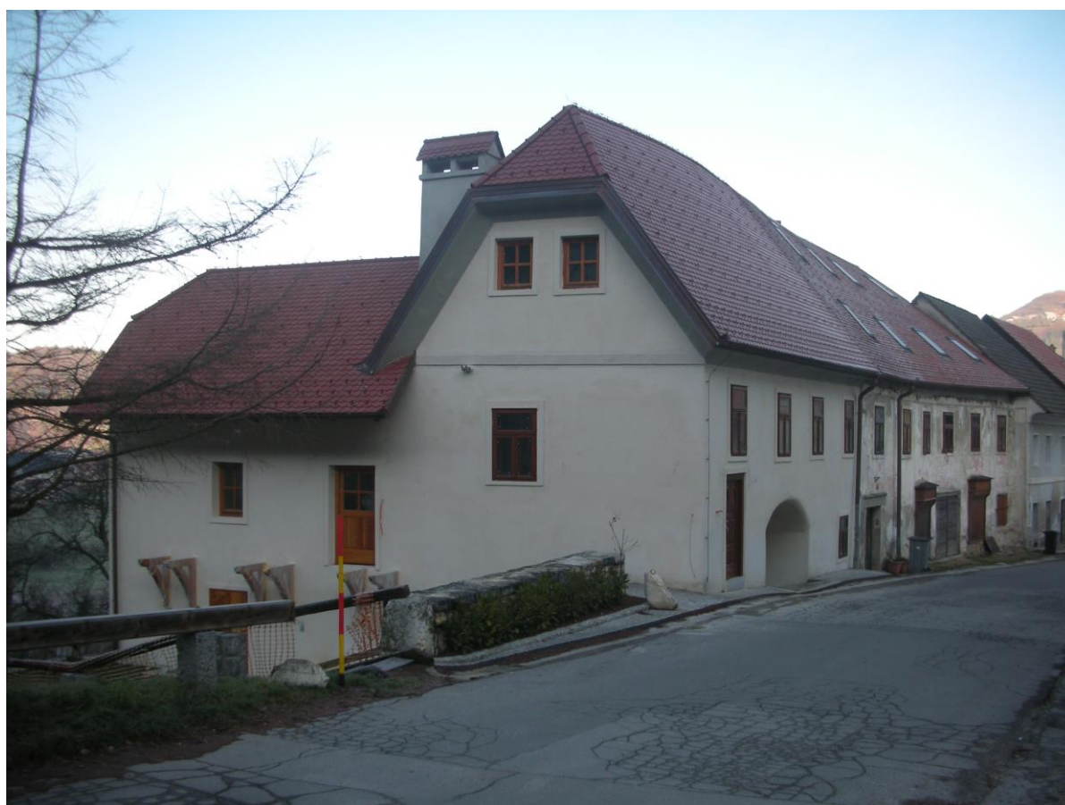
UTRDITEV IN SANACIJA HIŠE MESTNI TRG 1, VIŠNJA GORA
