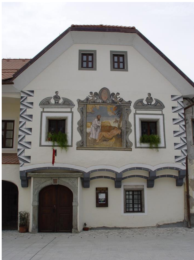
SANACIJA ŠIVČEVE HIŠE, RADOVLJICA
