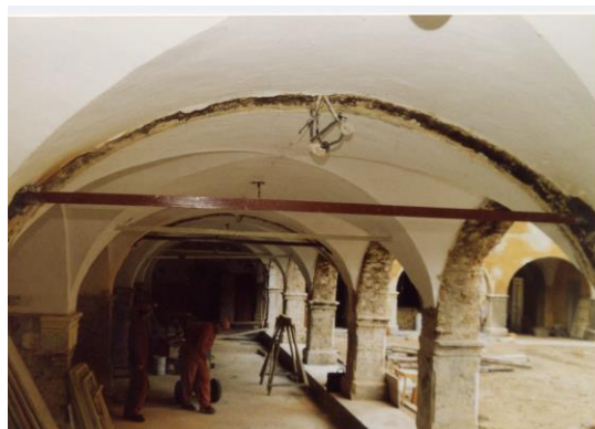
SANACIJA GRADU GRM, NOVO MESTO
