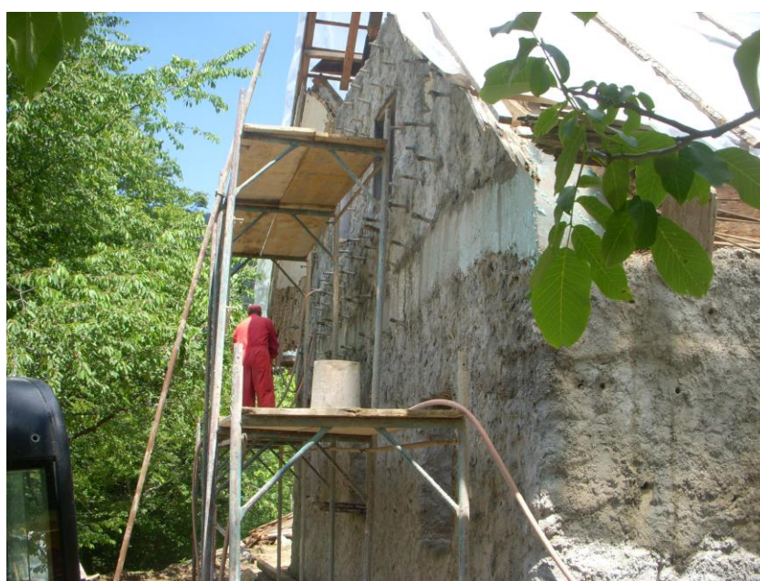
UTRDITEV ZIDOV IN SANACIJA VLAGE V OBJEKTIH KMETIJE VERLOČNIK, MATKOV KOT
