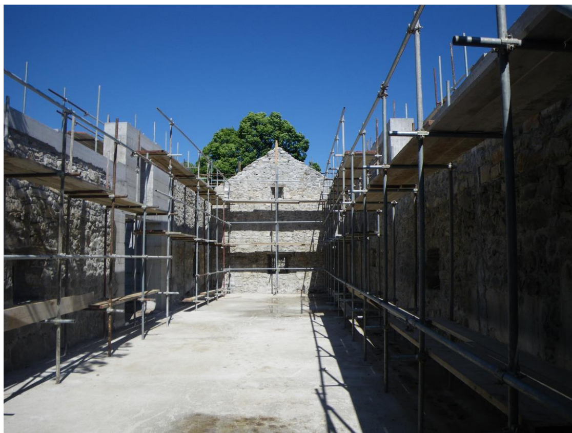
UTRDITEV IN SANACIJA OBJEKTOV ŠKRATELJNOVE DOMAČIJE, DIVAČA
