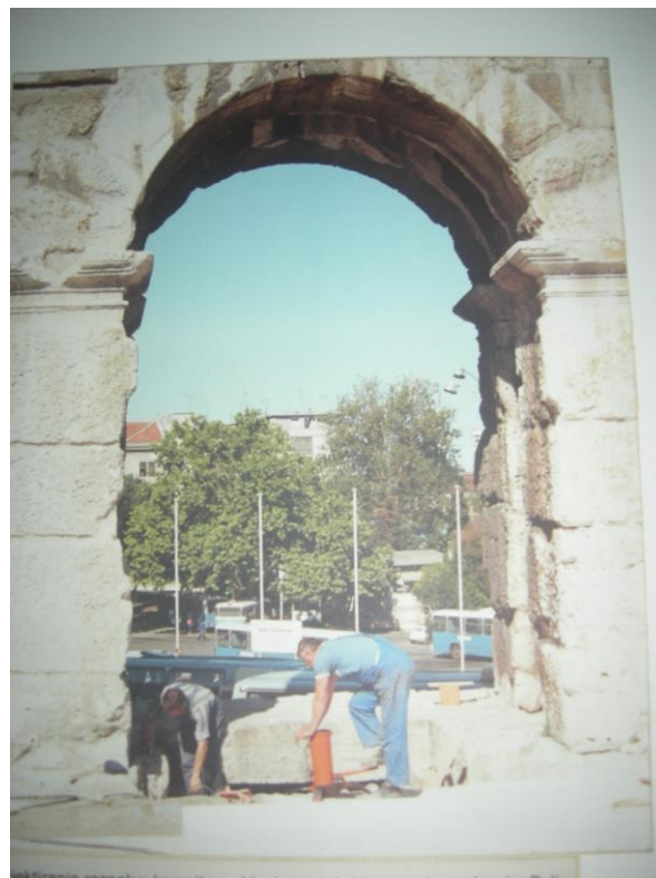
SANACIJA POŠKODB NOSILNIH STEBROV, ARENA v PULI, HRVAŠKA
