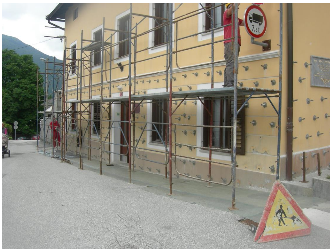
UTRDITEV KAMNITIH ZIDOV OBJEKTA ŽUPNIŠČE, BOVEC
