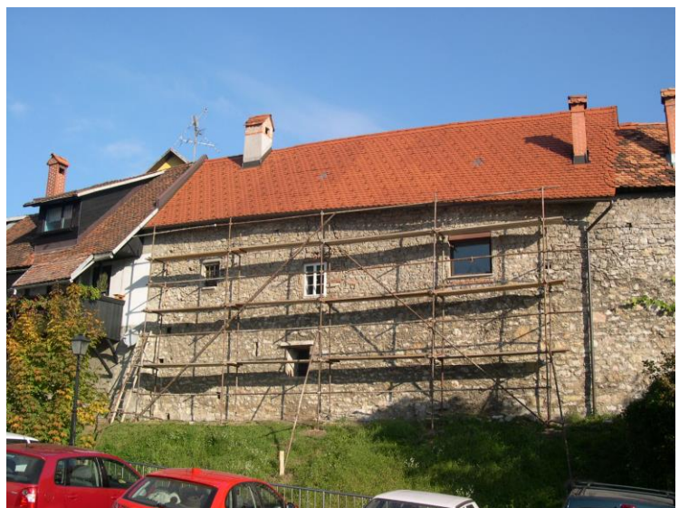
SANACIJA DELA MESTNEGA OBZIDJA, ŠKOFJA LOKA
