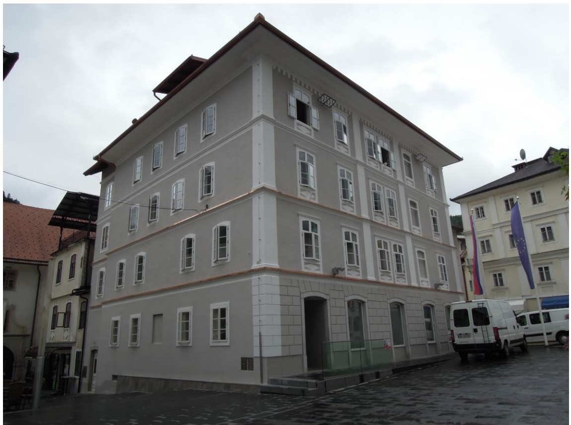
UTRDITEV KAMNITIH ZIDOV OBJEKTA MESTNI TRG 5, IDRJA
