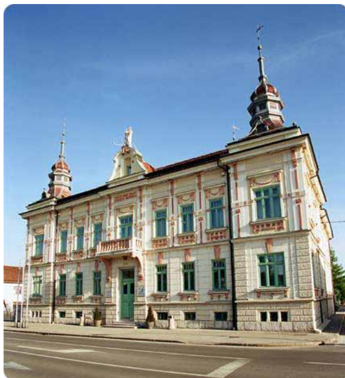
SANACIJA KULTURNEGA DOMA FRANCA BERNIKA, DOMŽALE
