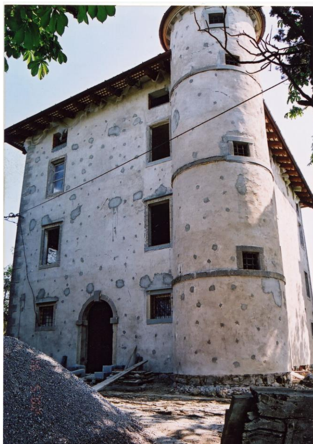
PROTIPOTRESNA UTRDITEV DVORCA CEGLO, GORIŠKA BRDA
