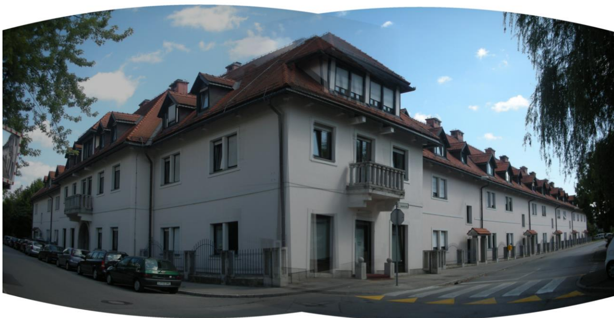
SANACIJA »KONJUŠNICE«, LJUBLJANA
