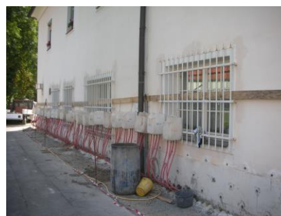
UTRDITEV IN SANACIJA VLAGE ZAŠČITENE HIŠE TOMŠIČEVA ULICA 11, KAMNIK
