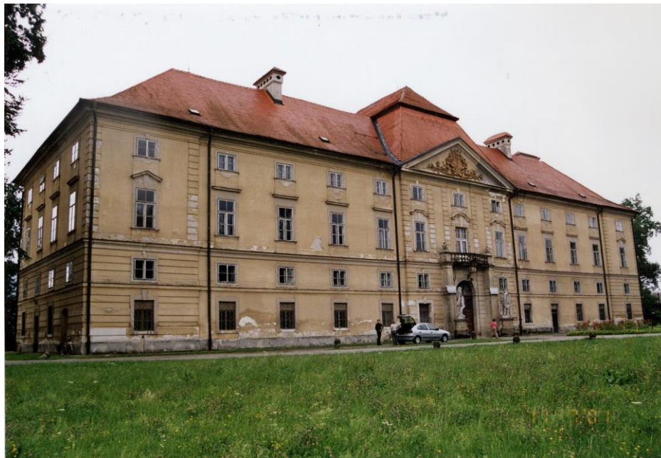
PROTIPOTRESNA SANACIJA DVORCA NOVO CELJE, ŽALEC
