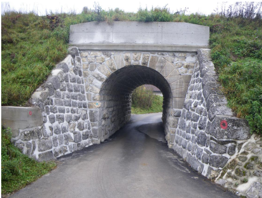
SANACIJA PODHODA, VELIKI GABER
