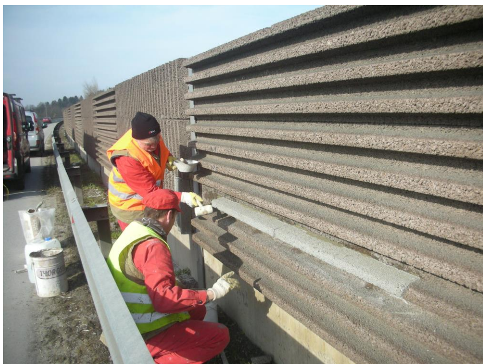
OBNOVA PROTIRUPNIH OGRAJ NA AC KRIŽU
