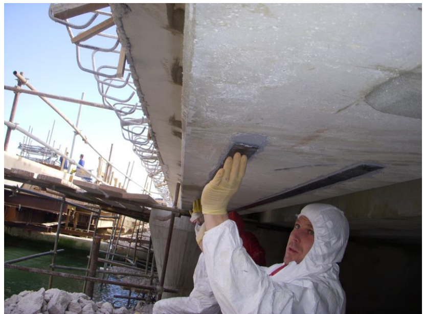
SANACIJA IN UTRDITEV MOSTU 5.2 NA CESTI KOPER – LUCIJA
