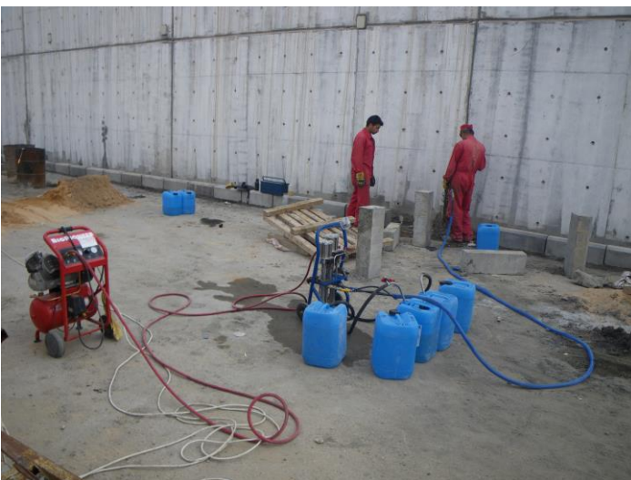
SANACIJA VTEKANJA NA OBJEKTU MOTORWAY UNDERPASS SAIF SAAD, KARBALA, IRAK
