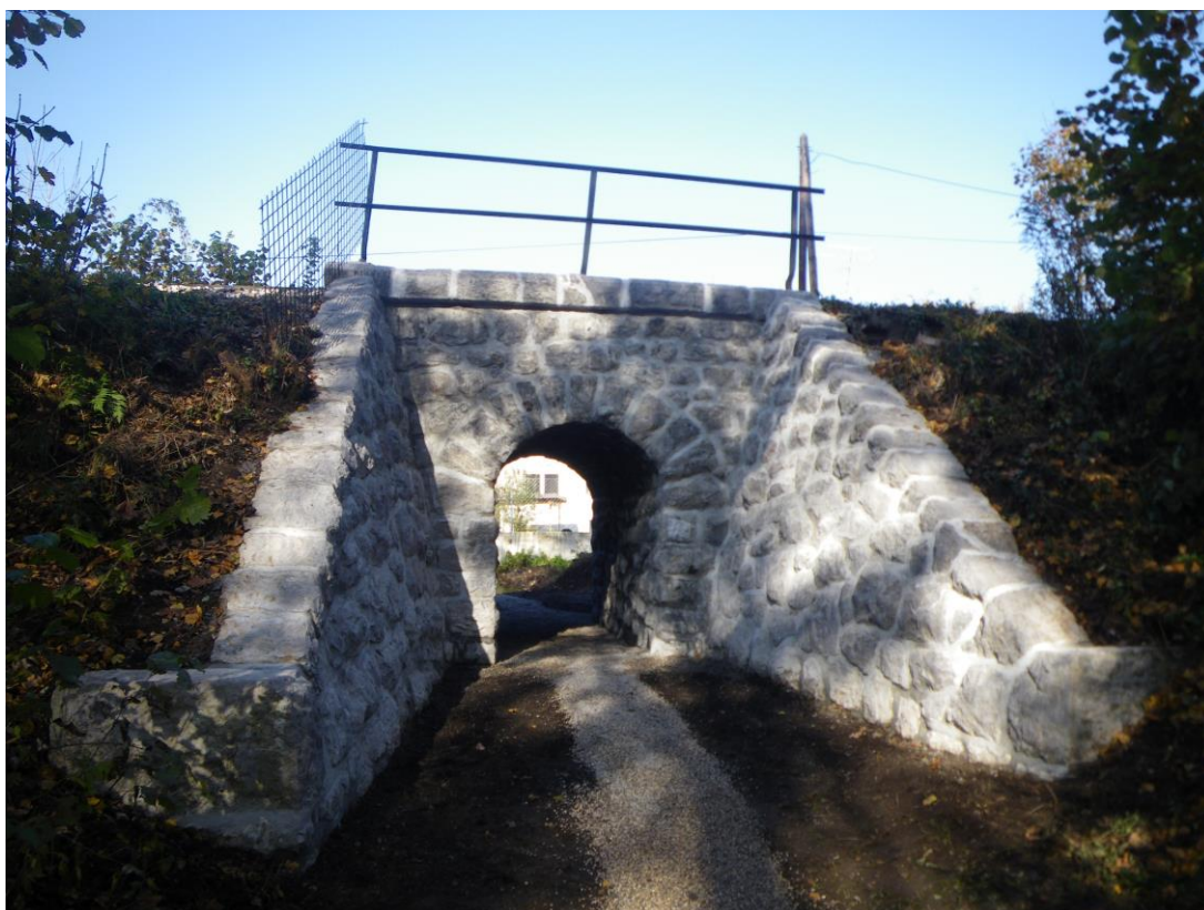
SANACIJA PODHODA, KODELJEVO LJUBLJANA
