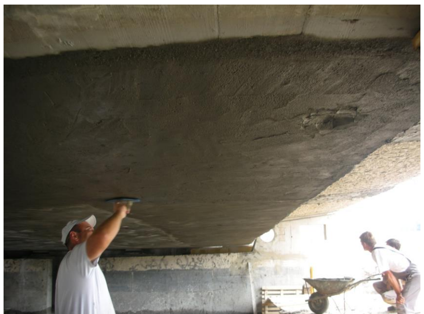
SANACIJA IN UTRDITEV MOSTU 4-2 NA CESTI KOPER – LUCIJA
