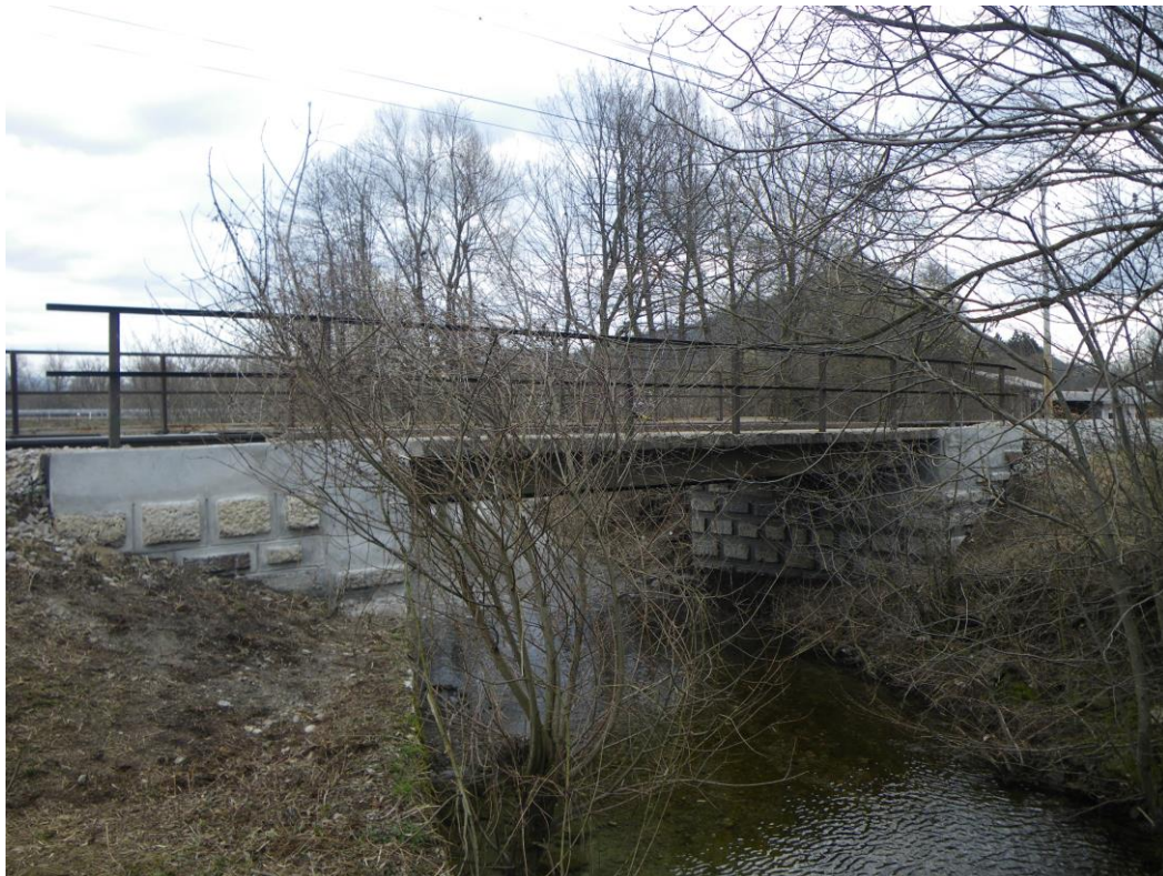
SANACIJA ŽELEZNIŠKEGA MOSTU, MEDNO
