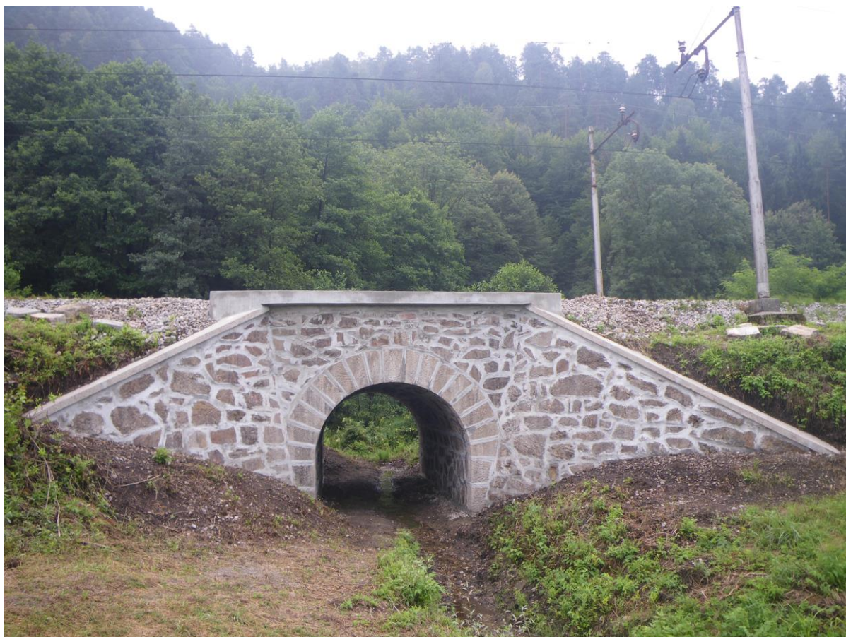
SANACIJA PODHODA, DOBROVA
