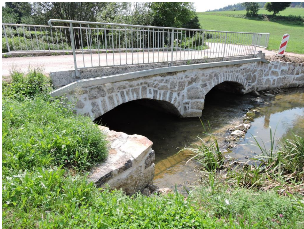
SANACIJA MOSTU PREKO TEMENICE, MIRNA PEČ
