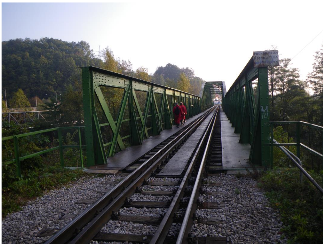
SANACIJA OPORNIKOV ŽELEZNIŠKEGA MOSTU, ČRNUČE
