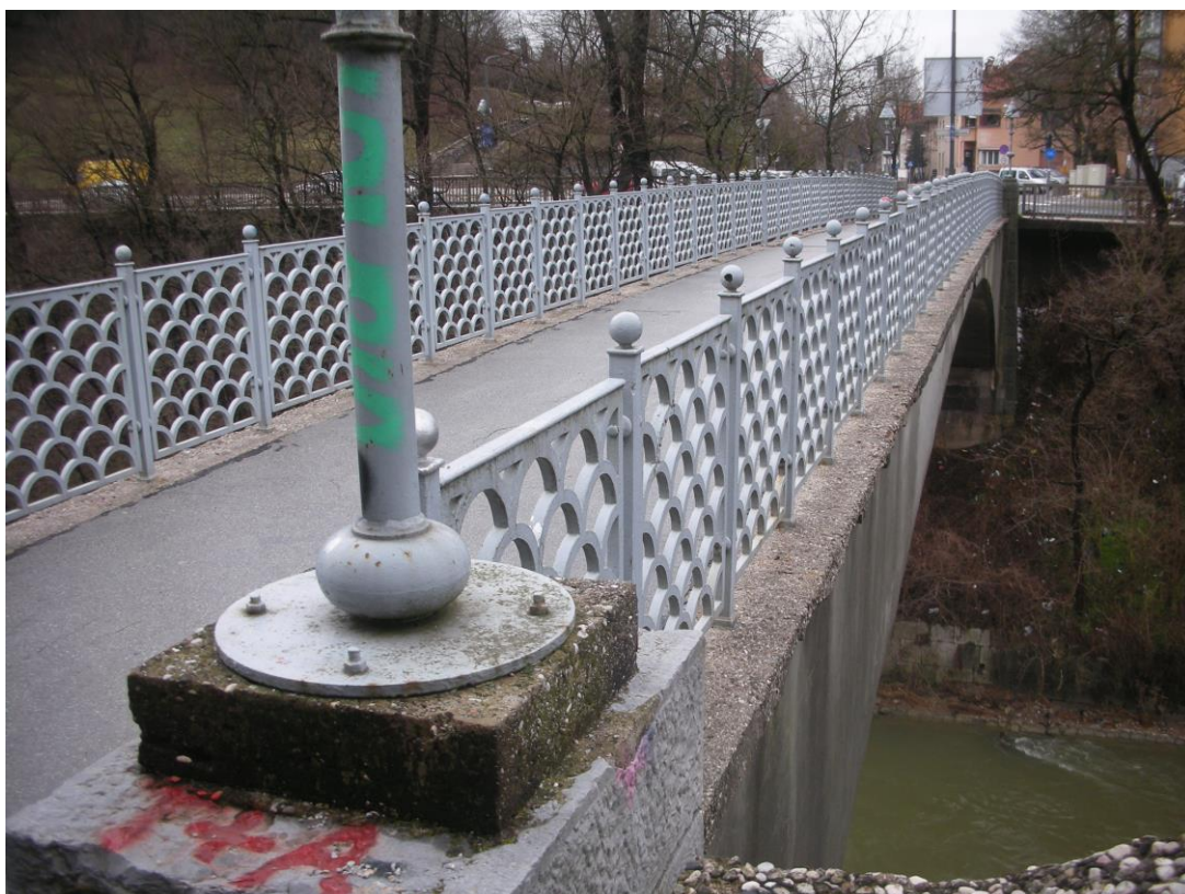
SANACIJA BRVI PREKO GRUBARJEVEGA KANALA, LJUBLJANA
