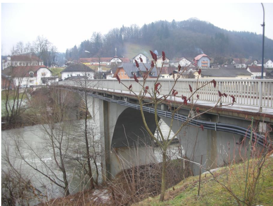
SANACIJA CESTNEGA MOSTU, GORIČANE
