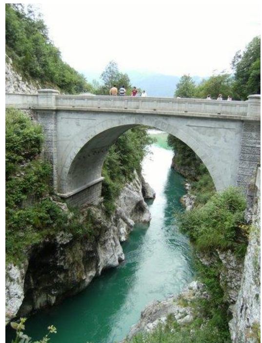
SANACIJA NAPOLEONOVEGA MOSTU, KOBARID
