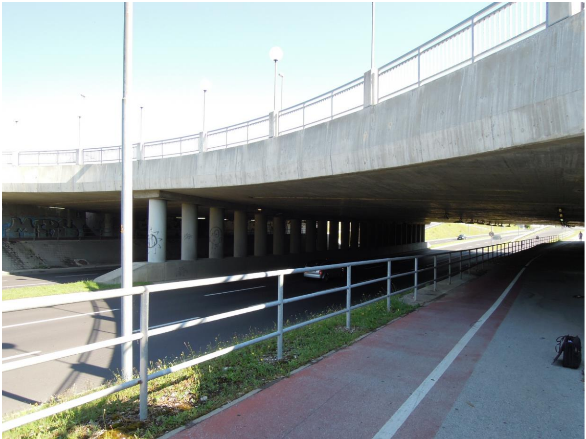
SANACIJA ZAMAKANJA ŽELEZNIŠKEGA VIADUKTA KOROŠKA CESTA MARIBOR
