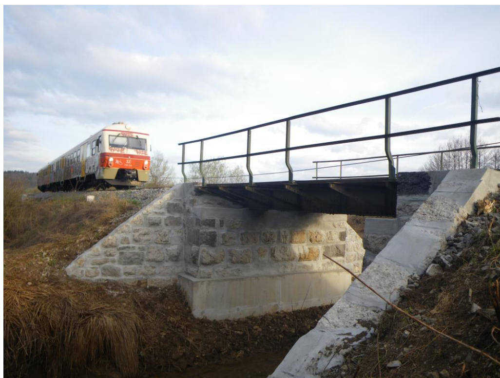
SANACIJA MOSTU PREKO TEMENICE
