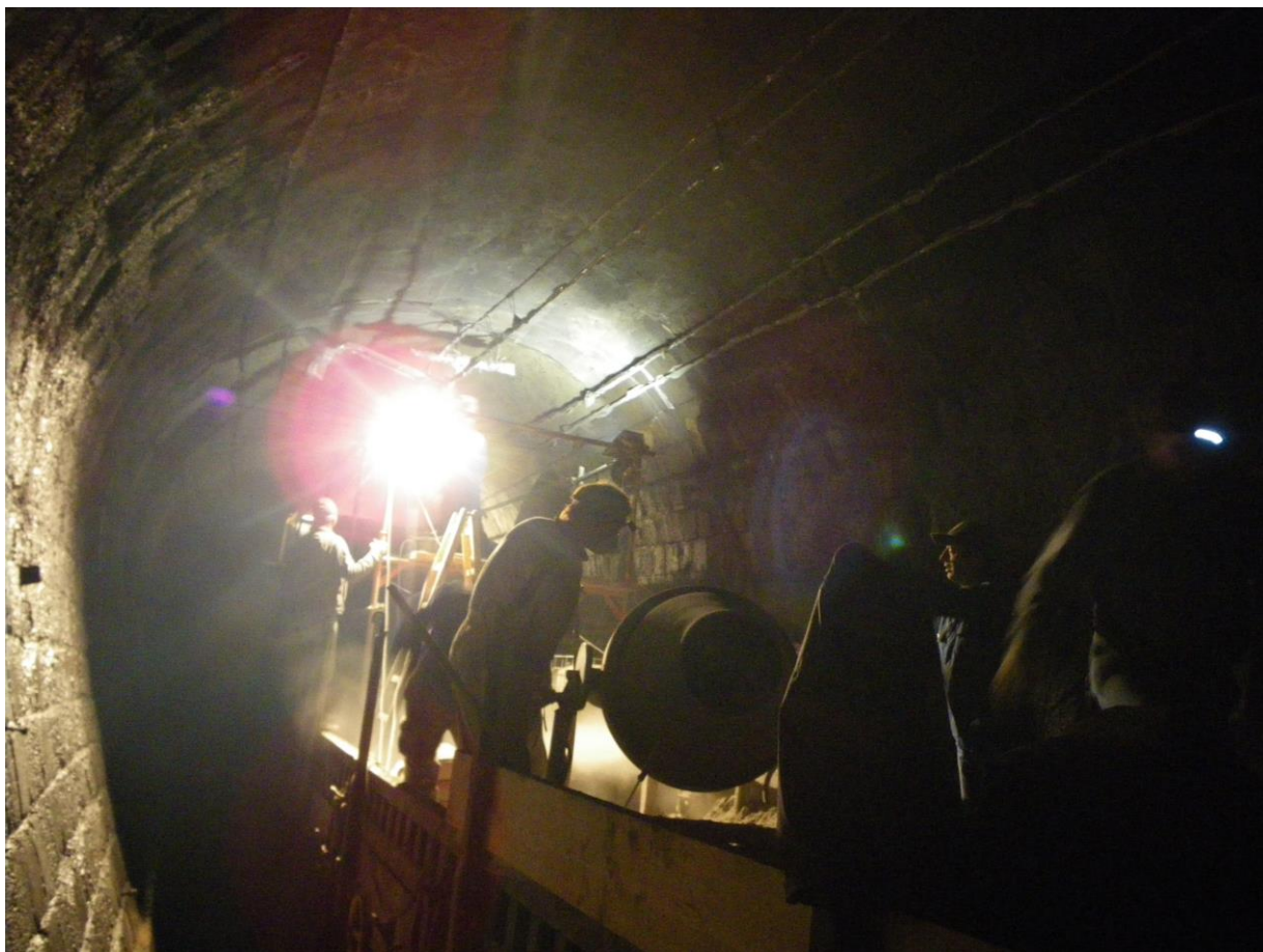
SANACIJA ŽELEZNIŠKEGA TUNELA GLOBOKO
