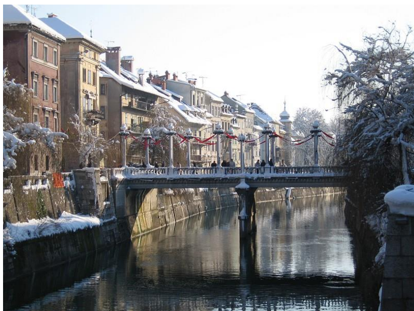
SANACIJA ČEVLJARSKEGA MOSTU, LJUBLJANA
