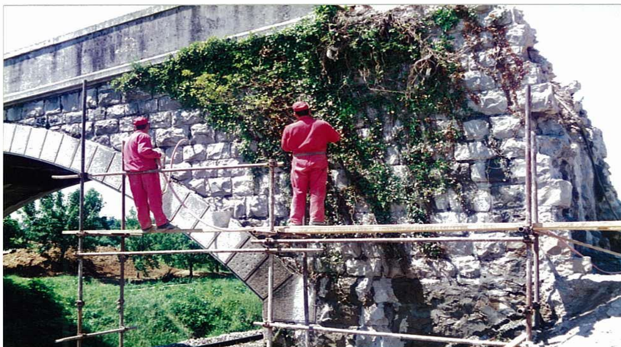
SANACIJA ŽELEZNIŠKEGA NADVOZA, ŠEMPETER
