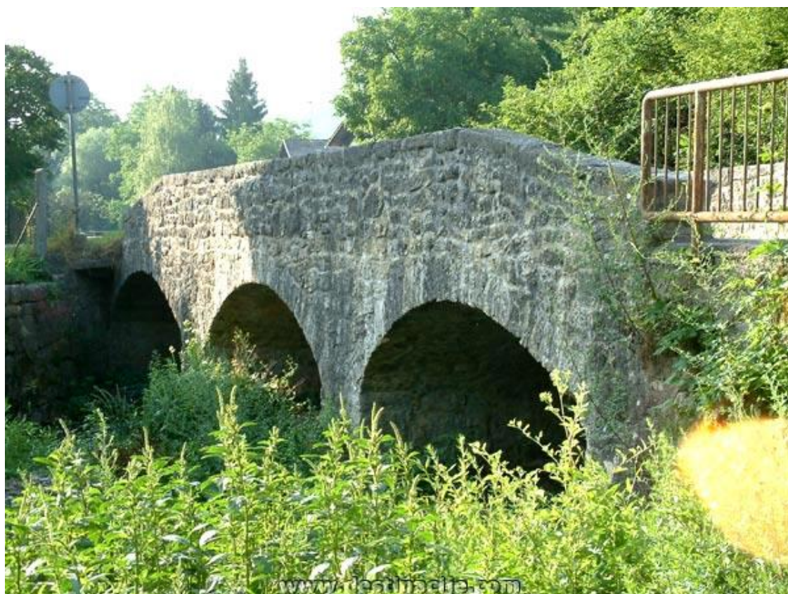
SANACIJA CESTNEGA MOSTU, PODBOČJE
