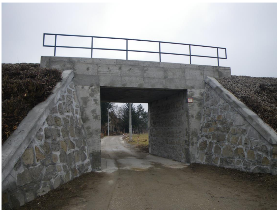
SANACIJA PODVOZA, UDVANČEVA ILICA, LJUBLJANA
