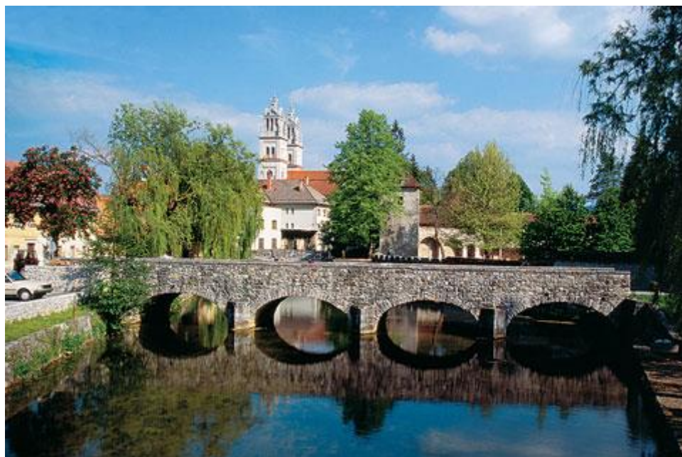
SANACIJA »GRAJSKEGA« MOSTU, RIBNICA
