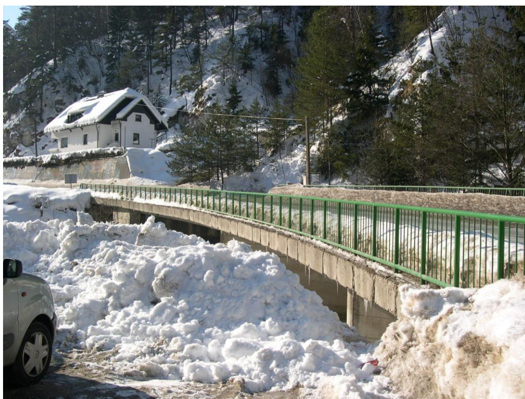
UTRDITEV CESTNEGA MOSTU, ČRNA NA KOROŠKEM
