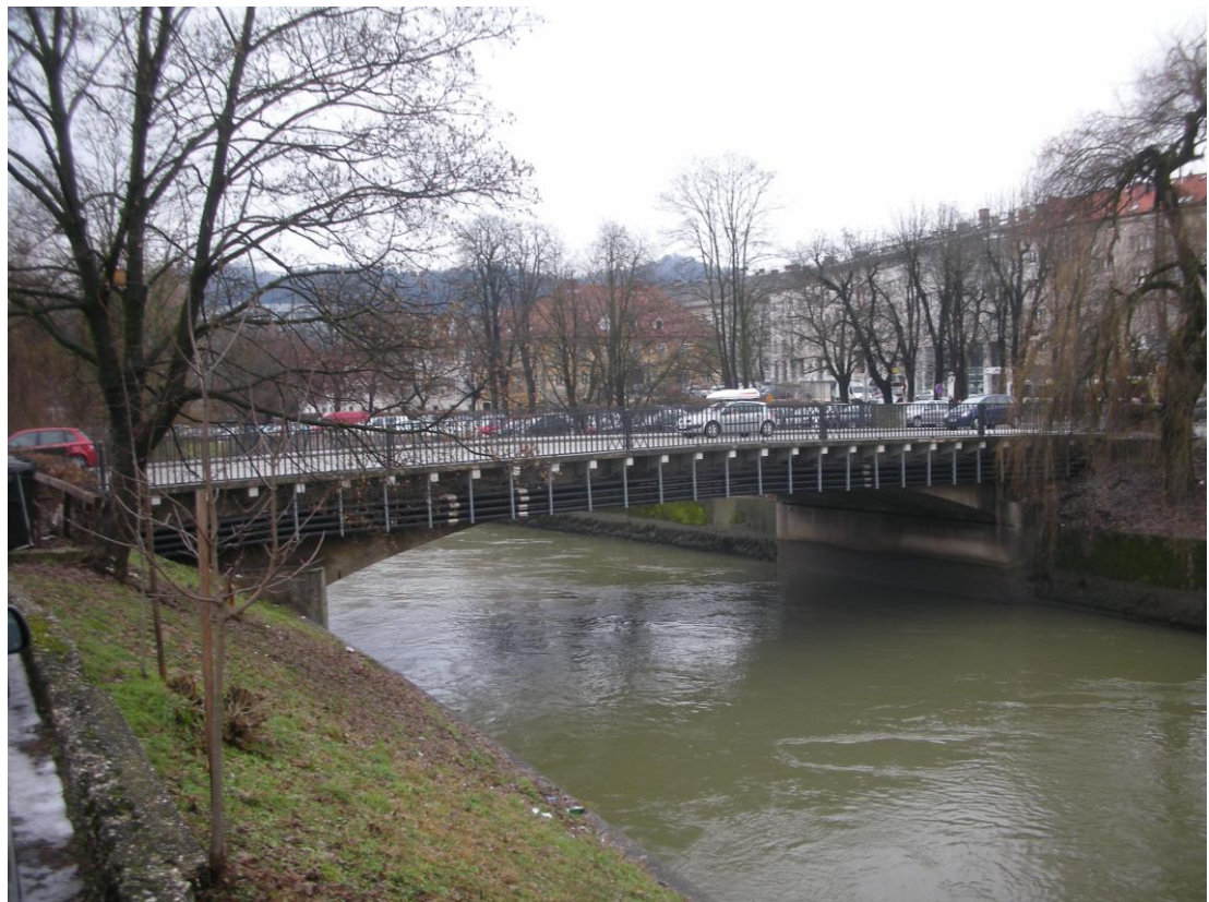
SANACIJA ŠEMPETERSKEGA MOSTU, LJUBLJANA
