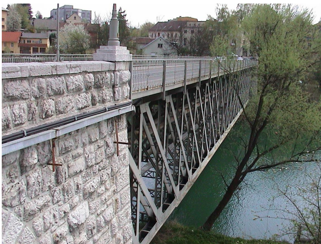
SANACIJA KANDIJSKEGA MOSTU, NOVO MESTO
