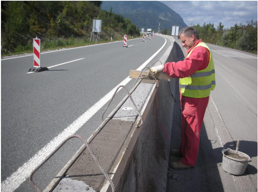
SANACIJA BVO ELEMENTOV, AC HRUŠICA-LIPCE
