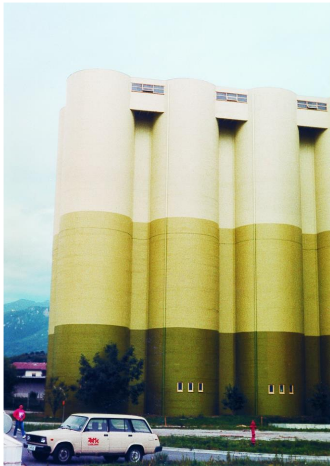
SANACIJA FASAD SILOSOV MLINOTEST, AJDOVŠČINA
