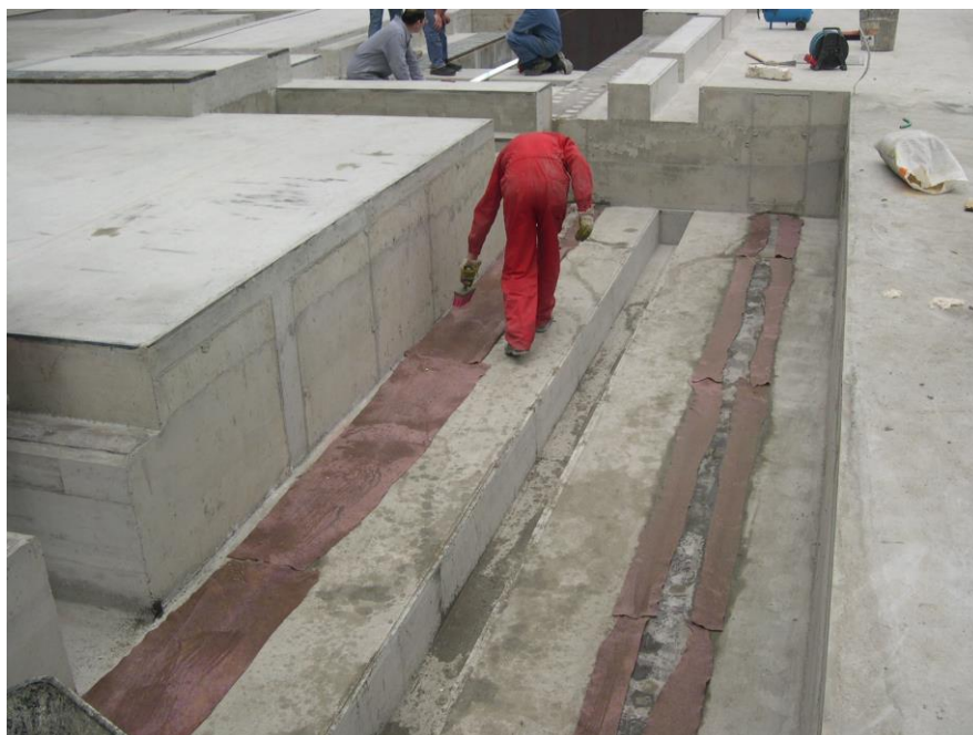
PODLIVANJE TEMELJA ŠKARIJ ZA PLOČEVINO, MERKUR NAKLO
