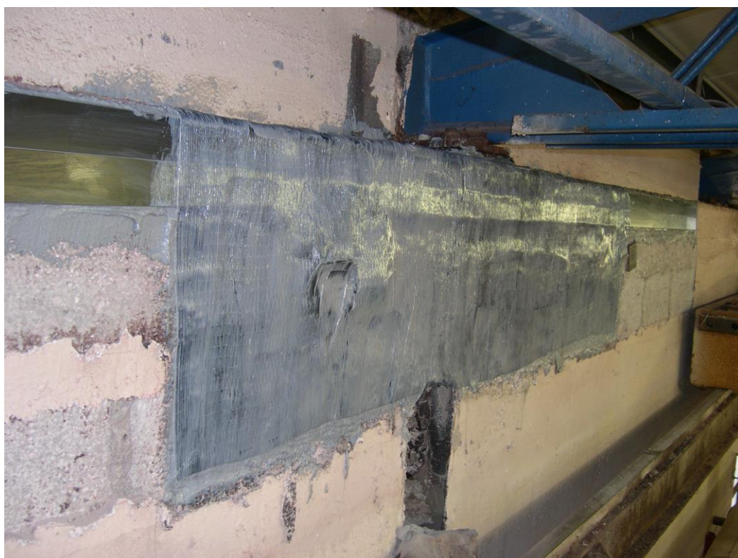
SANACIJA KONSTRUKCIJE PO EKSPLOZIJI, FENOLIT BOROVNICA
