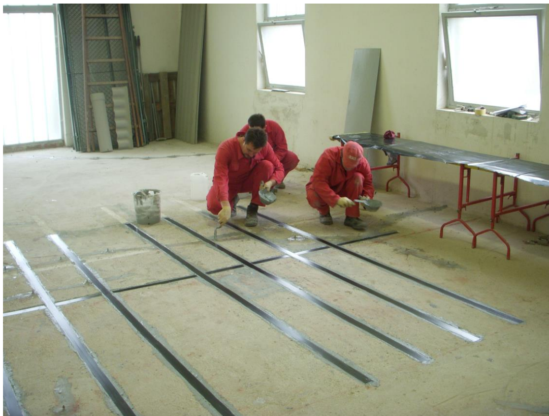
SANACIJA STROPNE KONSTRUKCIJE, RTP TOLMIN
