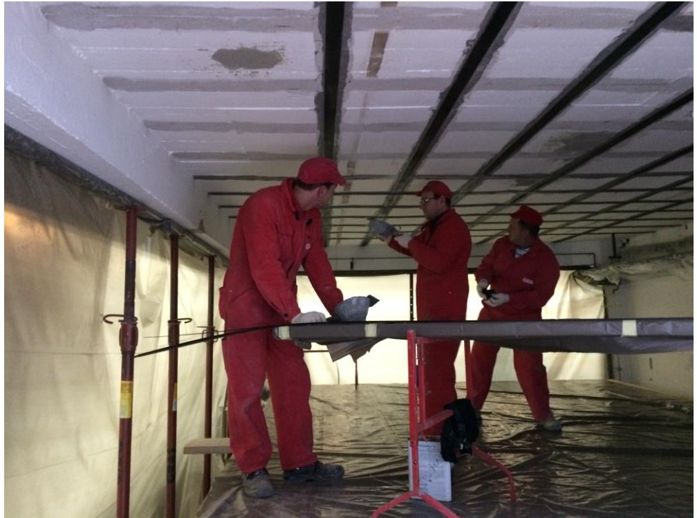
SATIČNA UTRDITEV AB STROPA, METROLOŠKI LABORATORIJ, GORENJE-VELENJE
