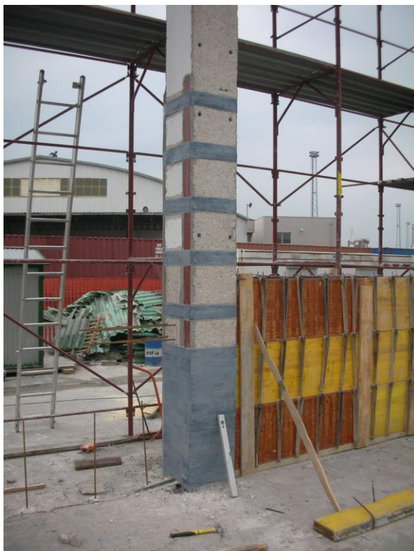
SANACIJA IN OJAČITEV STEBROV SKLADIŠČ 16 IN 19, LUKA KOPER
