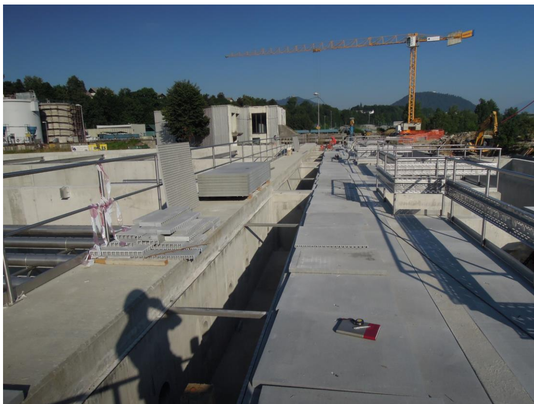
SANACIJA DELOVNIH STIKOV, ČISTILNA NAPRAVA KRANJ
