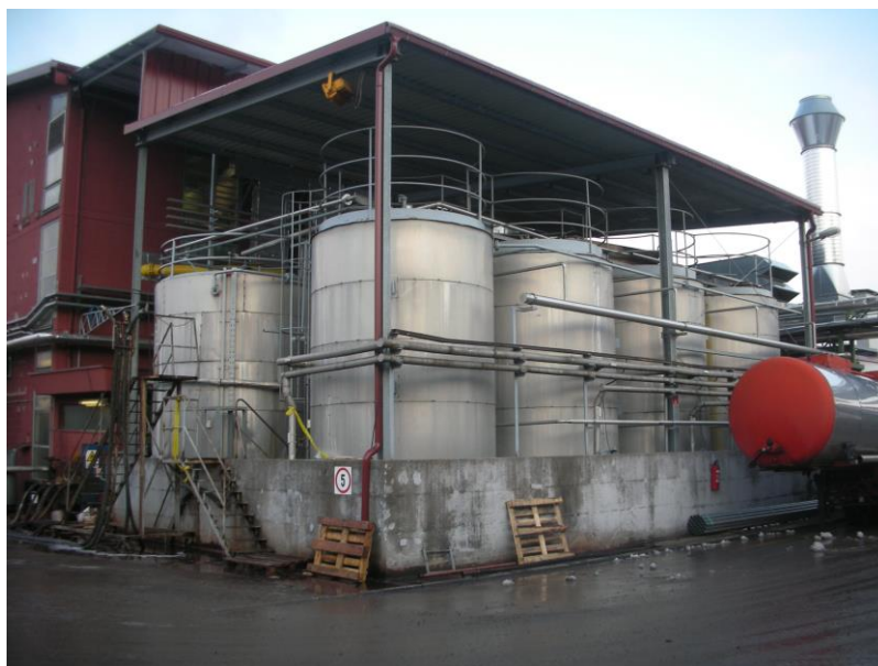
SANACIJA LOVILNE SKLEDE, FENOLIT BOROVNICA
