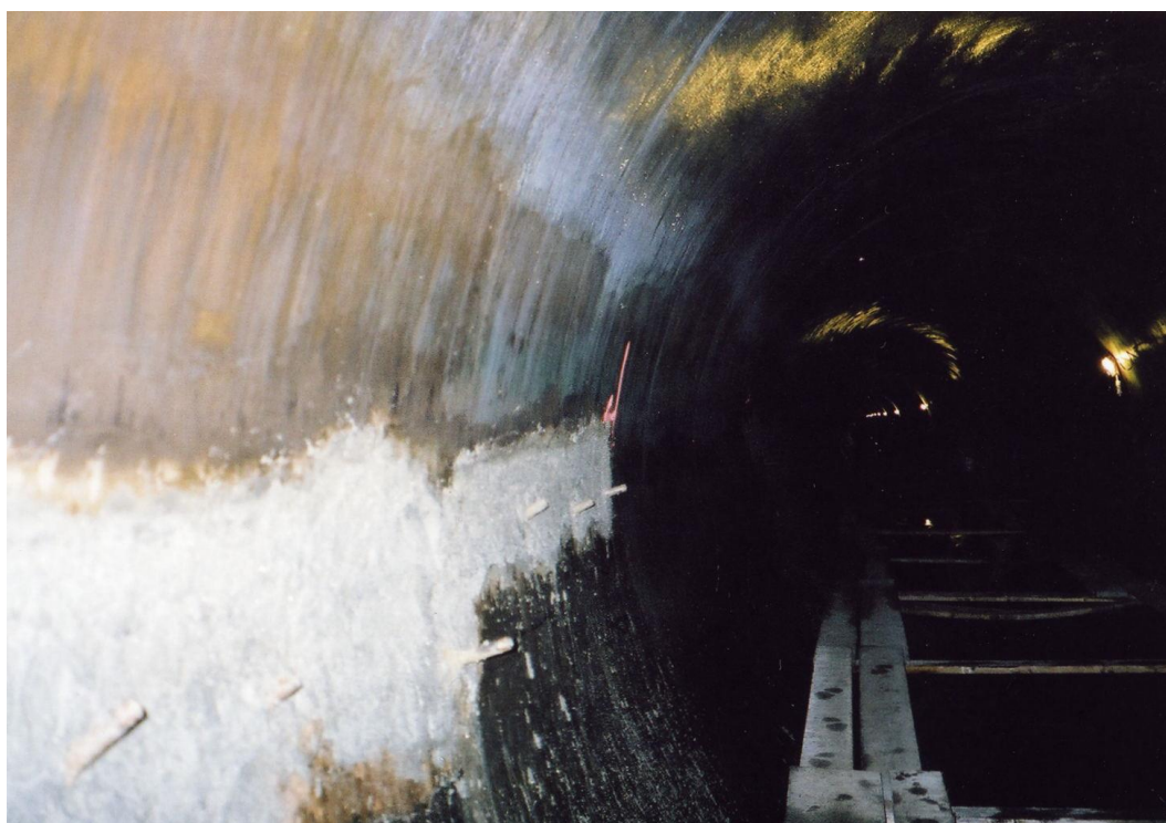
SANACIJA ODVODNEGA TUNELA HE MOSTE, ŽIROVNICA
