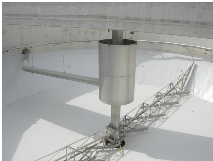
SANACIJA NOTRANJOSTI STAREGA VSEDALNIKA ČISTILNE NAPRAVE, PAPIRNIČA VEVČE
