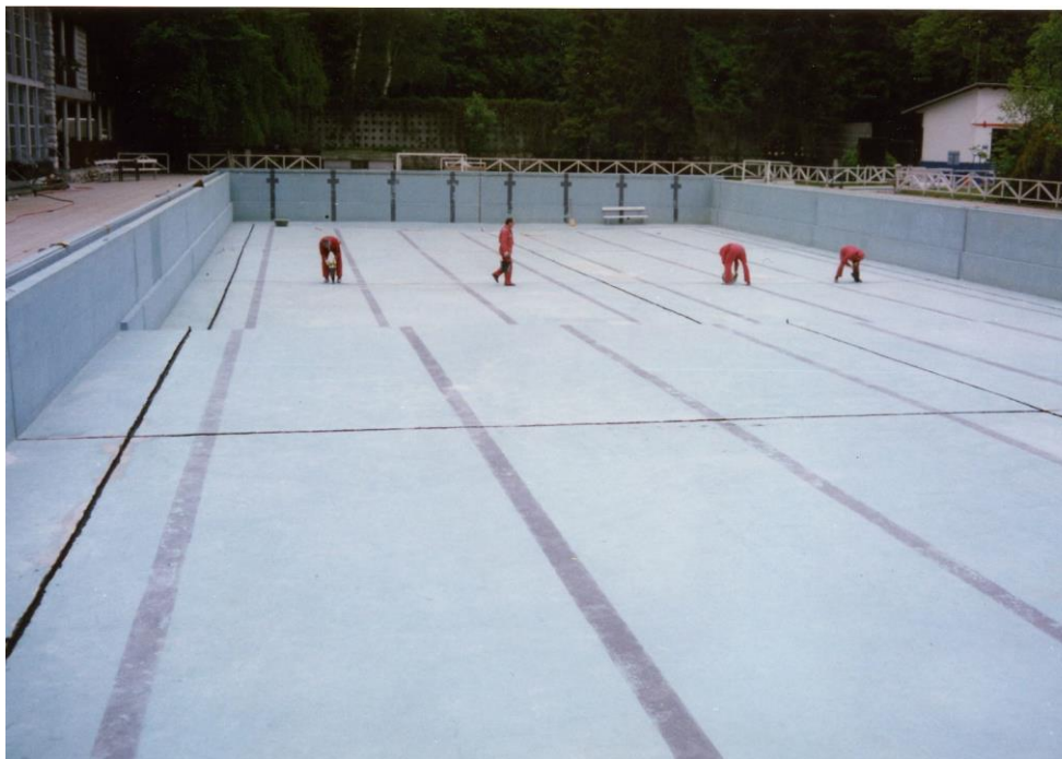
SANACIJA PLAVALNEGA BAZENA, KAMNIK
