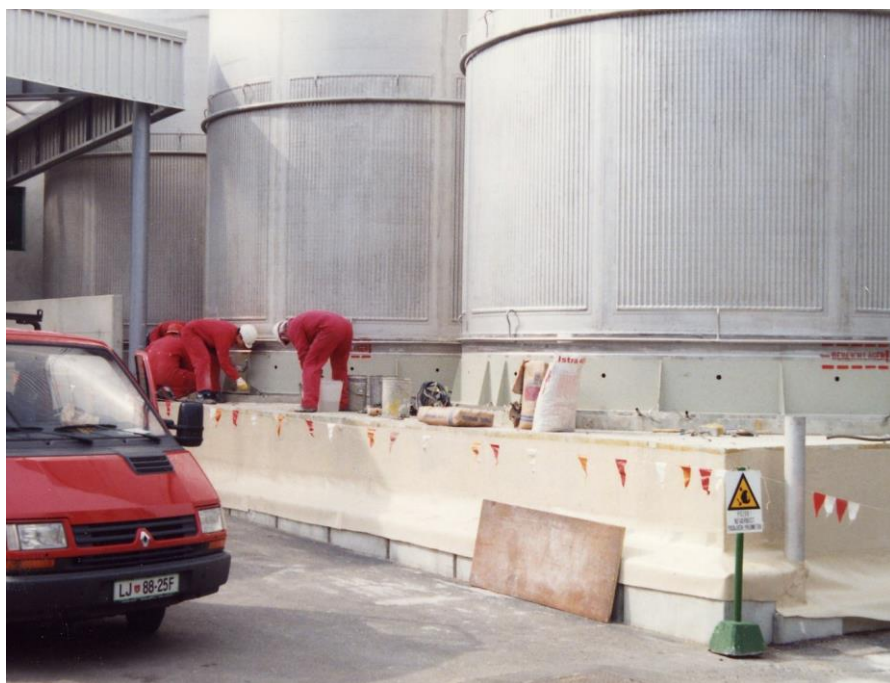
SIDRANJE IN PODLIVANJE CISTERN, PIVOVARNA LAŠKO
