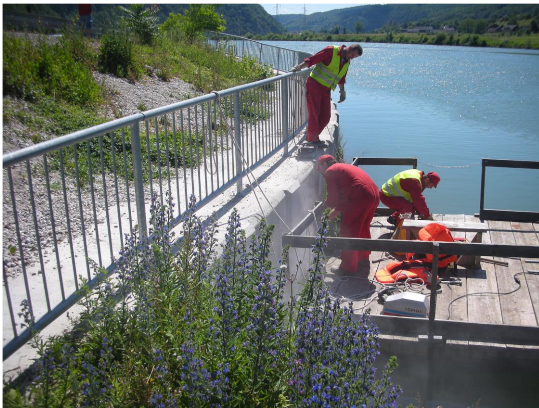
SANACIJA POŠKODB NA PILOTNI STENI, HE BLANCA
