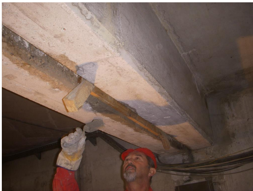
SANACIJA DILATACIJE, GH BISTRA, DOMŽALE
