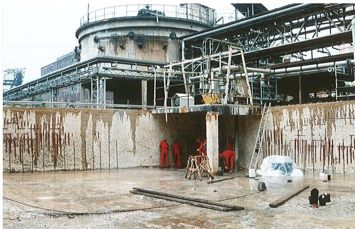
SANACIJA BAZENA ZA ODPADNE VODE, CINKARNA CELJE
