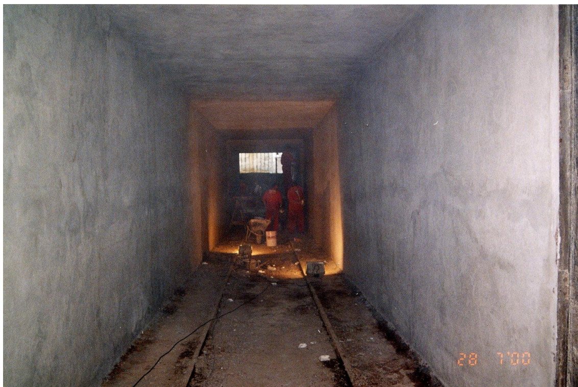
SANACIJA VLAŽILNIH KOMOR V TOVARNI LESONIT, ILIRSKA BISTRICA
