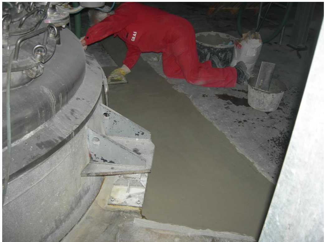
SANACIJA KONSTRUKCIJE PO RAZLITJU KISLINE, MELAMIN KOČEVJE
