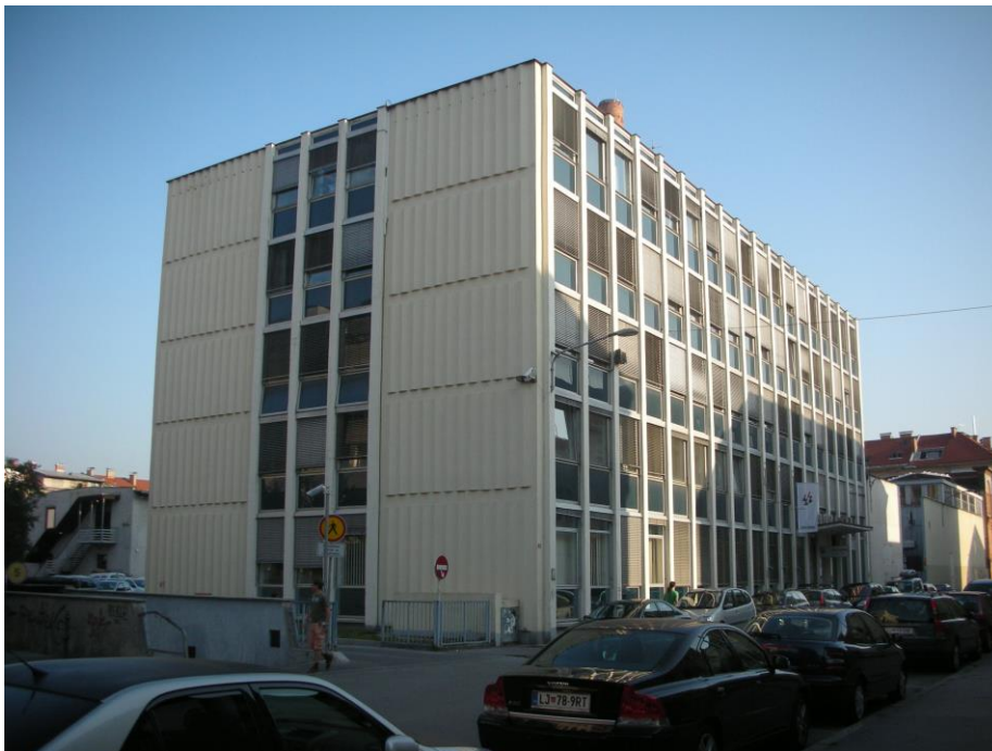
SANACIJA FASADE UPRAVNE STAVBE ELEKTRO LJUBLJANA
