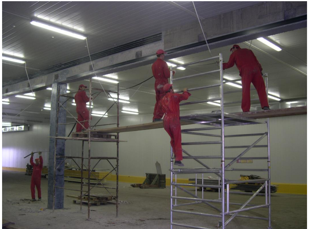
OJAČITEV OKVIRNE KONSTRUKCIJE V SKLADIŠČNI HALI, LUKA KOPER
