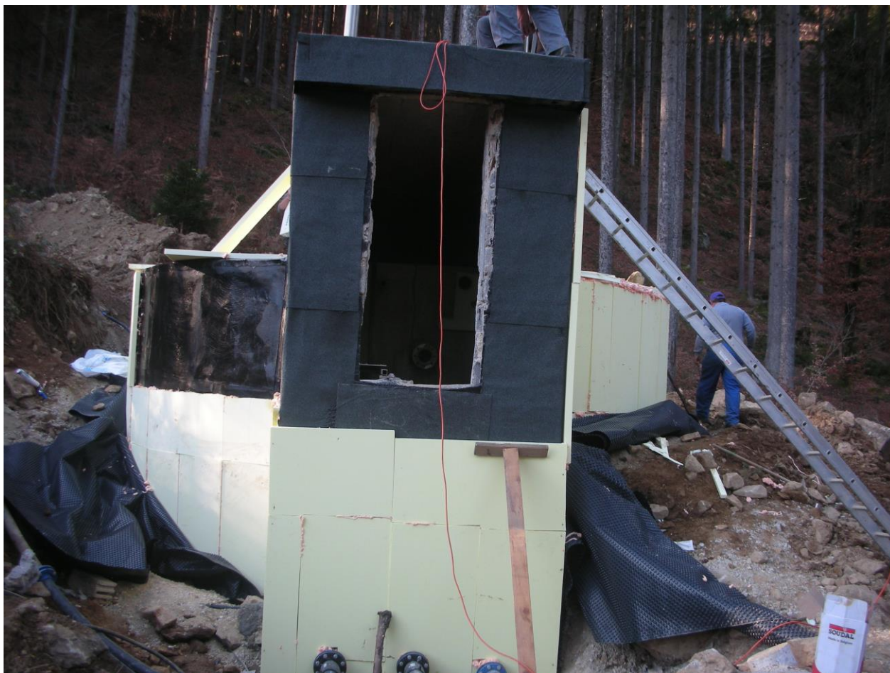
SANACIJA IN ZAŠČITA NOTRANJOSTI VODOHRAMA FUŽINE, GORENJA VAS
