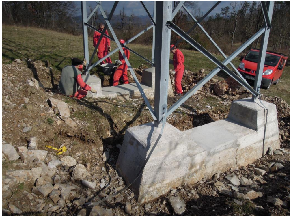
SANACIJA TEMELJEV 110 KV DALJNOVODA PIVKA-POSTOJNA
