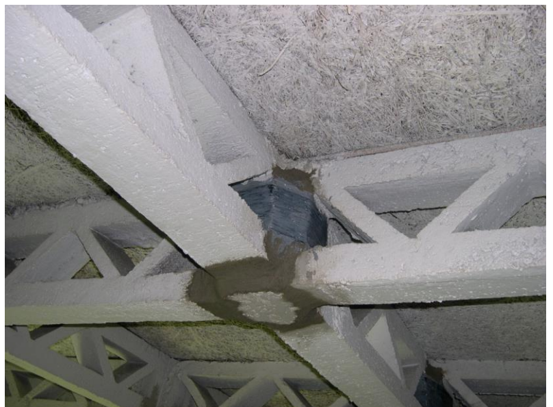
SANACIJA STREŠNE KONSTRUKCIJE, ETRA 33 LJUBLJANA
