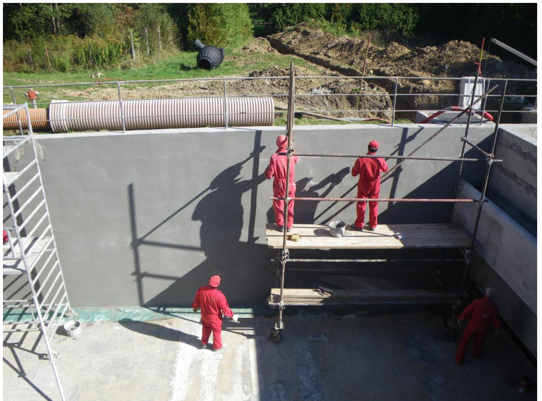
SANACIJA POVRŠIN BAZENOV, ČISTILNA NAPRAVA RIBNICA
