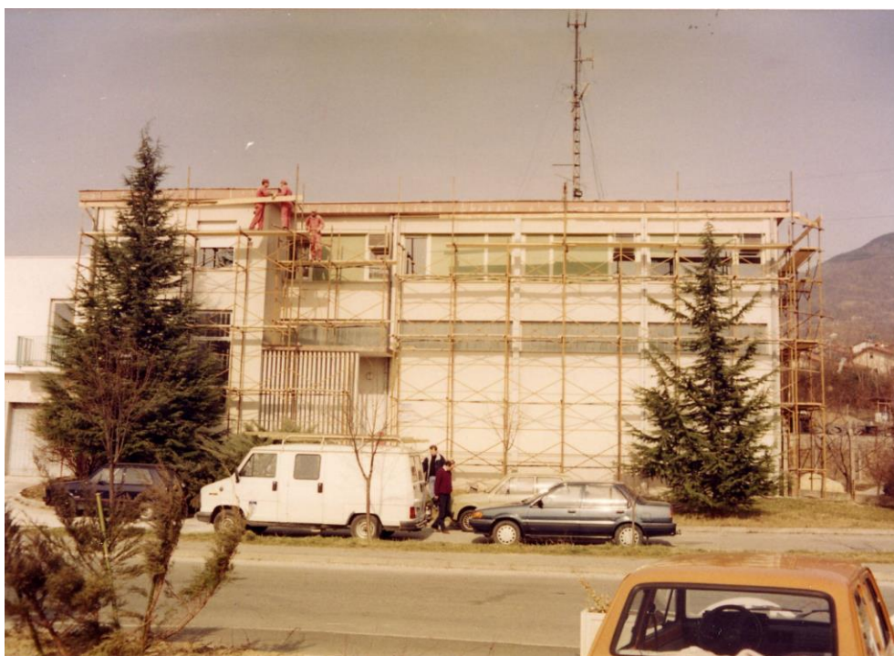
SANACIJA FASADE RTP, NOVA GORICA
