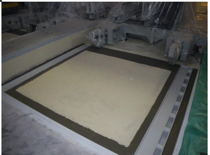
PODLIVANJE ELEMENTOV STROJNE OPREME, ETRA 33, LJUBLJANA
