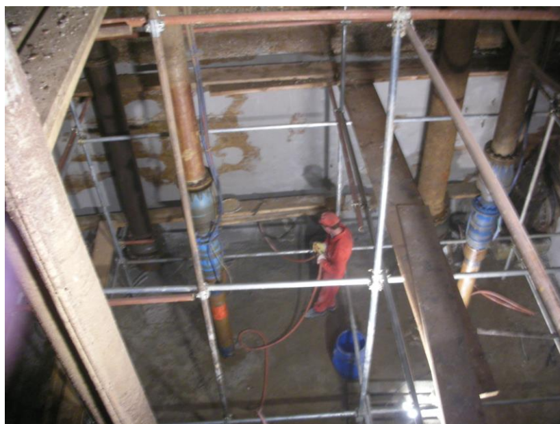
SANACIJA ČRPALIŠČA REČNE VODE, KRKA NOVO MESTO
