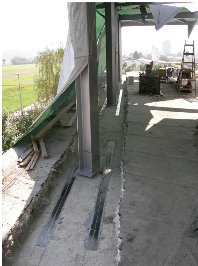
STATIČNA UTRDITEV STROPNE KONSTRUKCIJE, RAZVOJNI CENTER HELIOS, DOMŽALE
