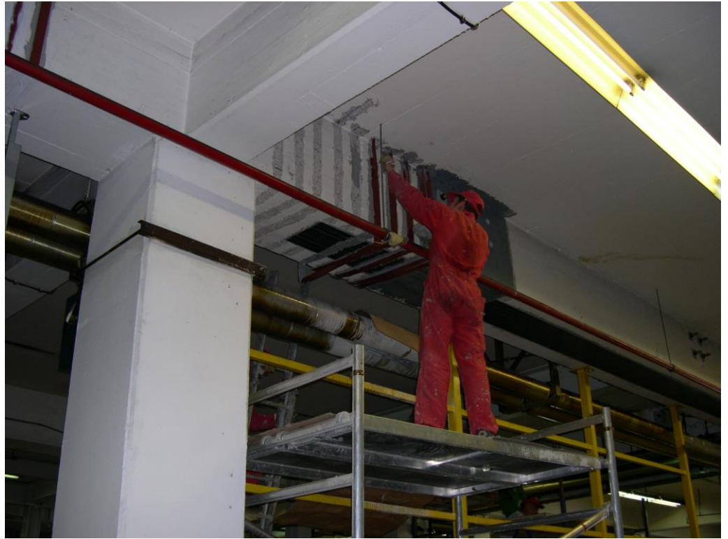
OJAČITEV STROPNIH KONSTRUKCIJ, REVOZ NOVO MESTO
