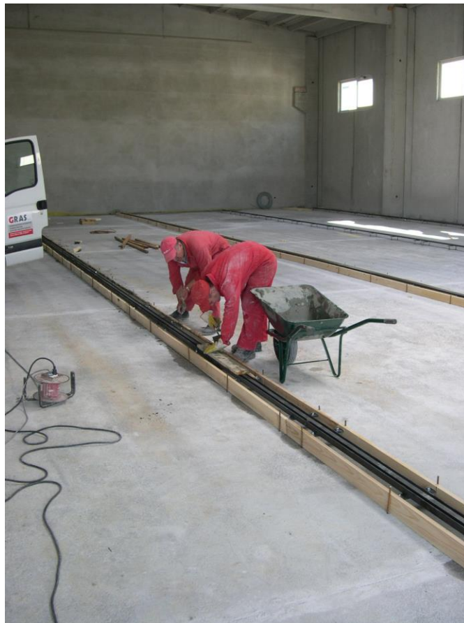
PODLIVANJE TIRNIC, OPLAST TEPANJE
