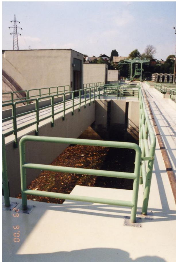
SANACIJA KROVA HIDROELEKTRARNE MAVČIČE
