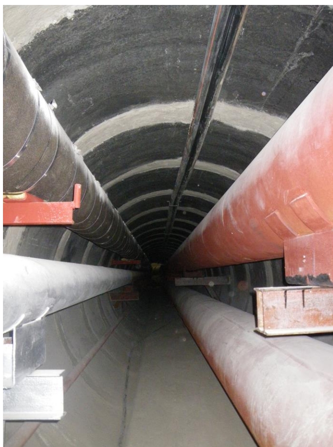
SANACIJA PARNEGA IN VROČEVODNEGA KOLEKTORJA, LJUBLJANA
