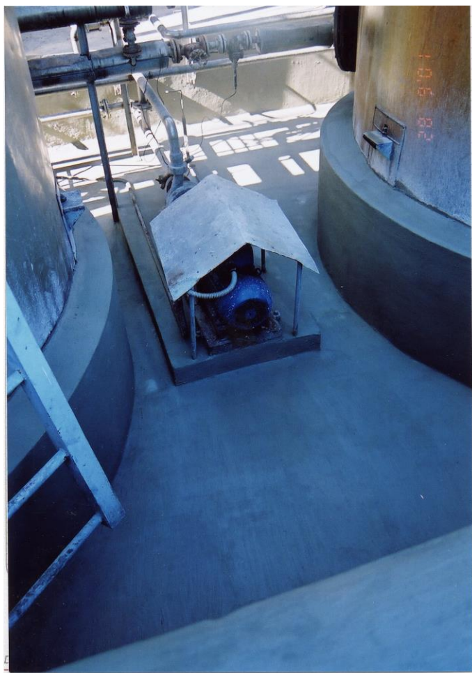
SANACIJE KONSTRUKCIJ V KEMIČNI TOVARNI MELAMIN, KOČEVJE
