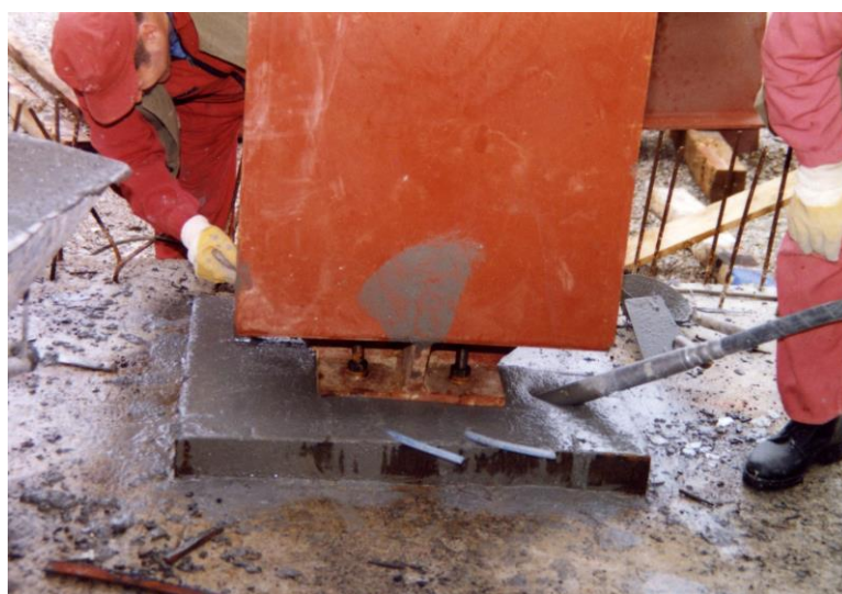
PODLIVANJE PODLOŽNIH PLOČEVIN STEBROV, POŠTNI CENTER LJUBLJANA
