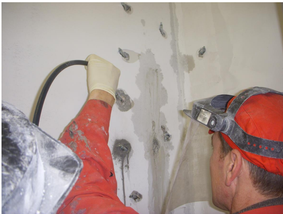
SANACIJA VTEKANJA, ČISTILNA NAPRAVA ŠKOFJA LOKA
