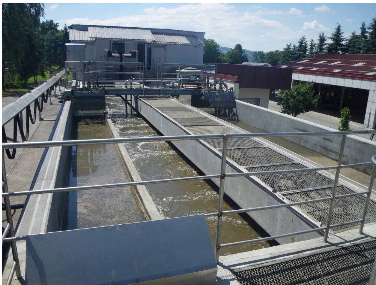
SANACIJA VSEDALNIH BAZENOV, CČN DOMŽALE – KAMNIK
