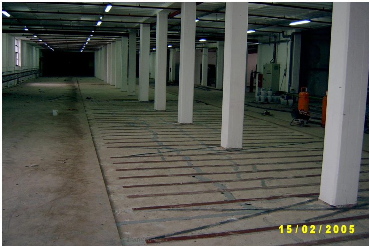
SANACIJA IN OJAČITEV STROPNE KONSTRUKCIJE, PALOMA CERŠAK
