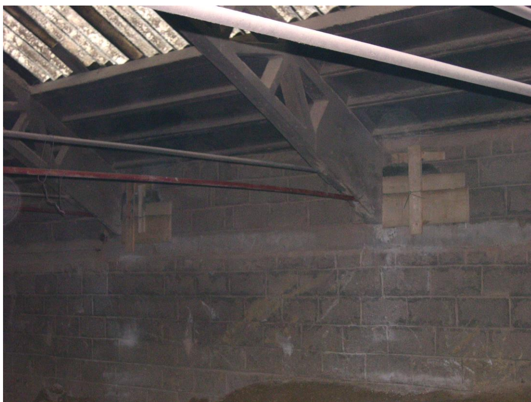
SANACIJA STREŠNE KONSTRUKCIJE, TOVARNA KERAMIKE GORENJE
