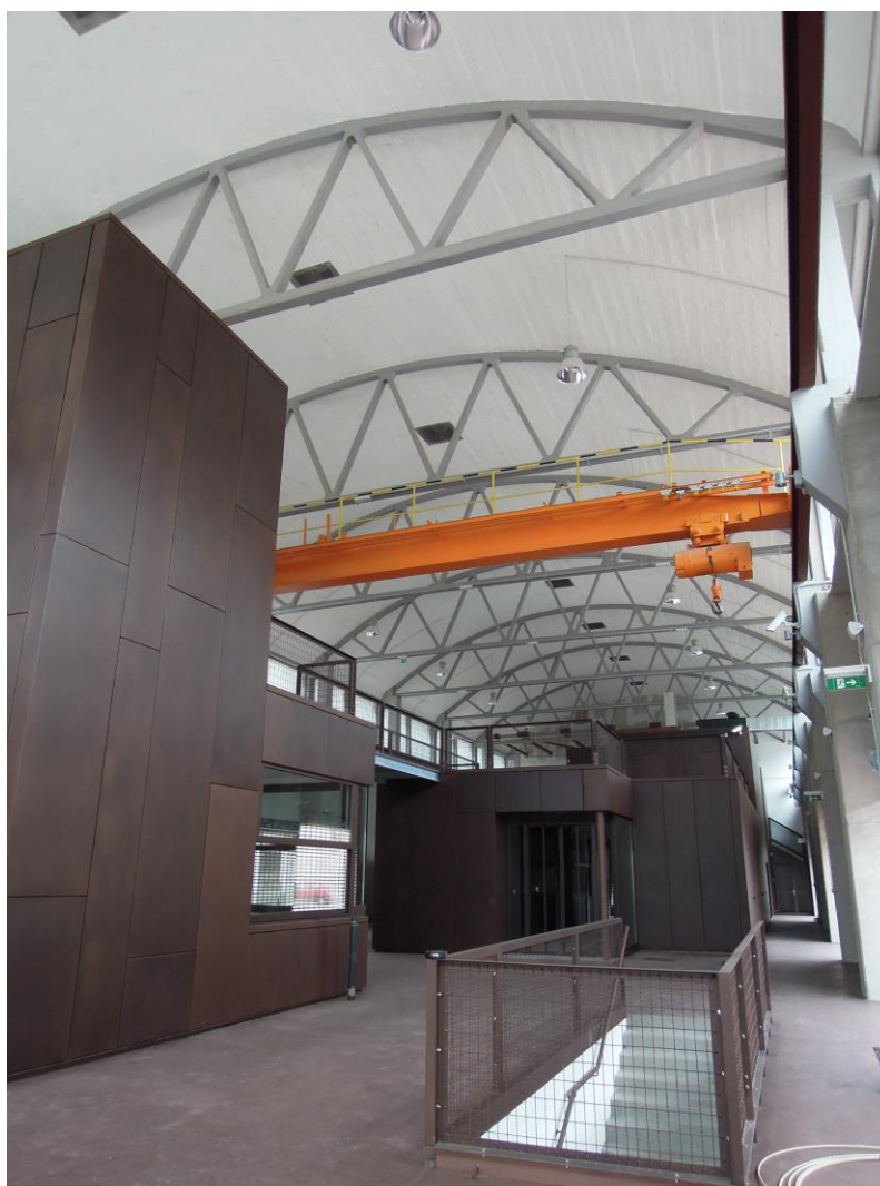
SANACIJA AB STREŠNIH KONSTRUKCIJ OBJEKTOV URBANO SREDIŠČE STARA SAVA, JESENICE
