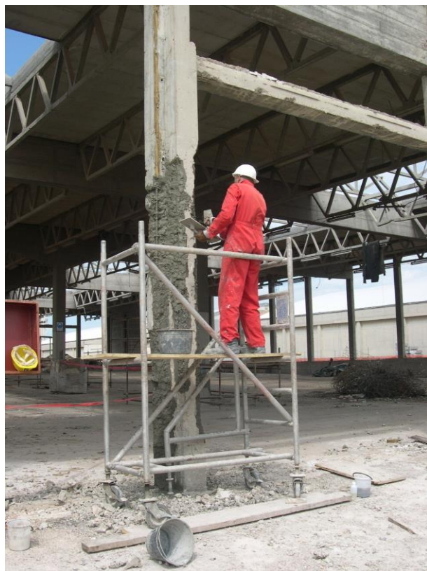
SANACIJA IN OJAČITEV STEBROV SKLADIŠČ 16 IN 19, LUKA KOPER
