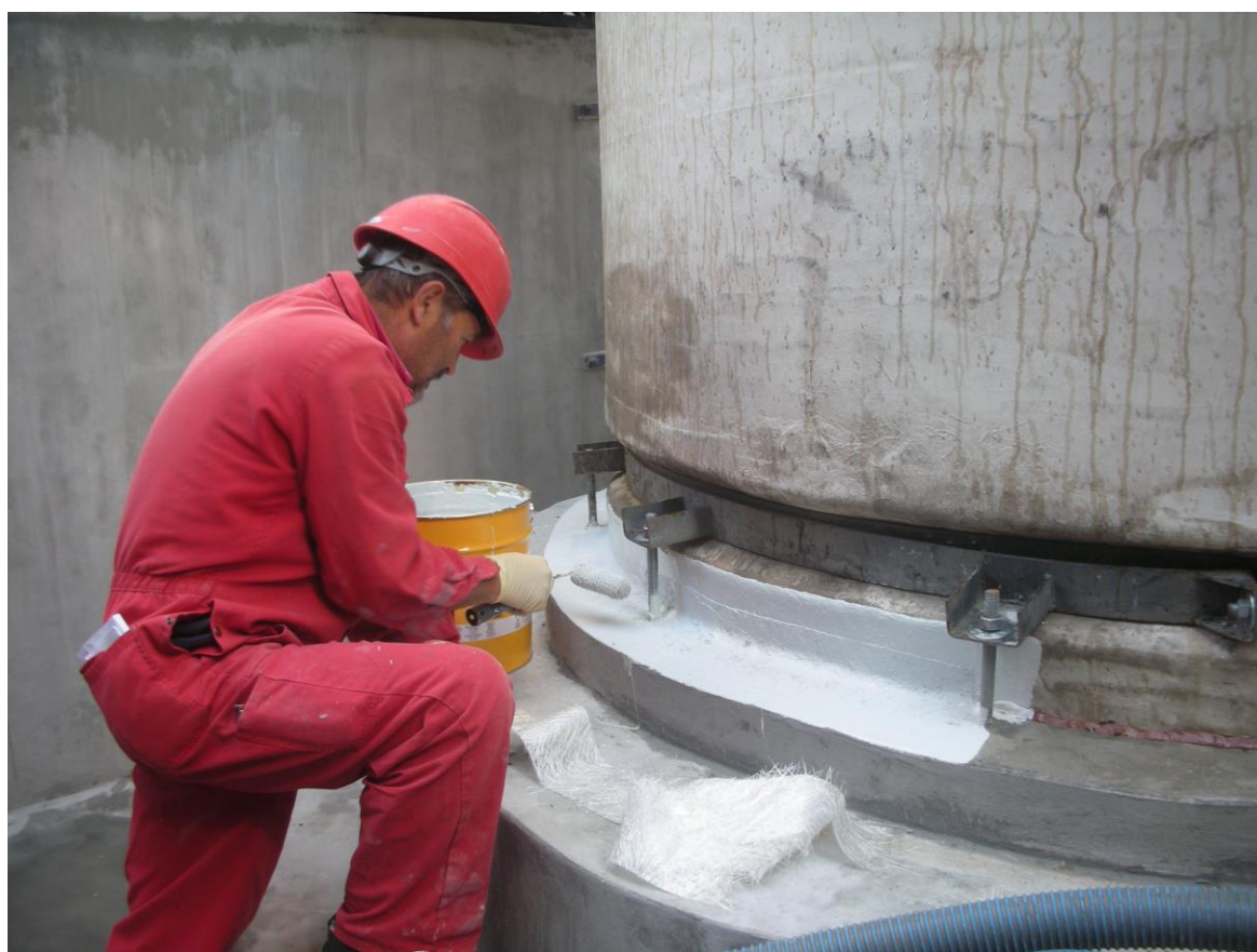
SANACIJA LOVILNIH BAZENOV, MELAMIN, KOČEVJE
