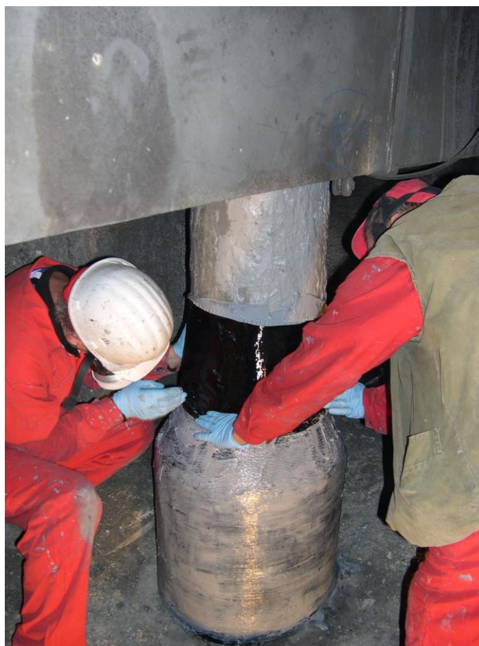
SANACIJA IN OJAČITEV STEBROV TOPILNICE, MPI ŽERJAV
