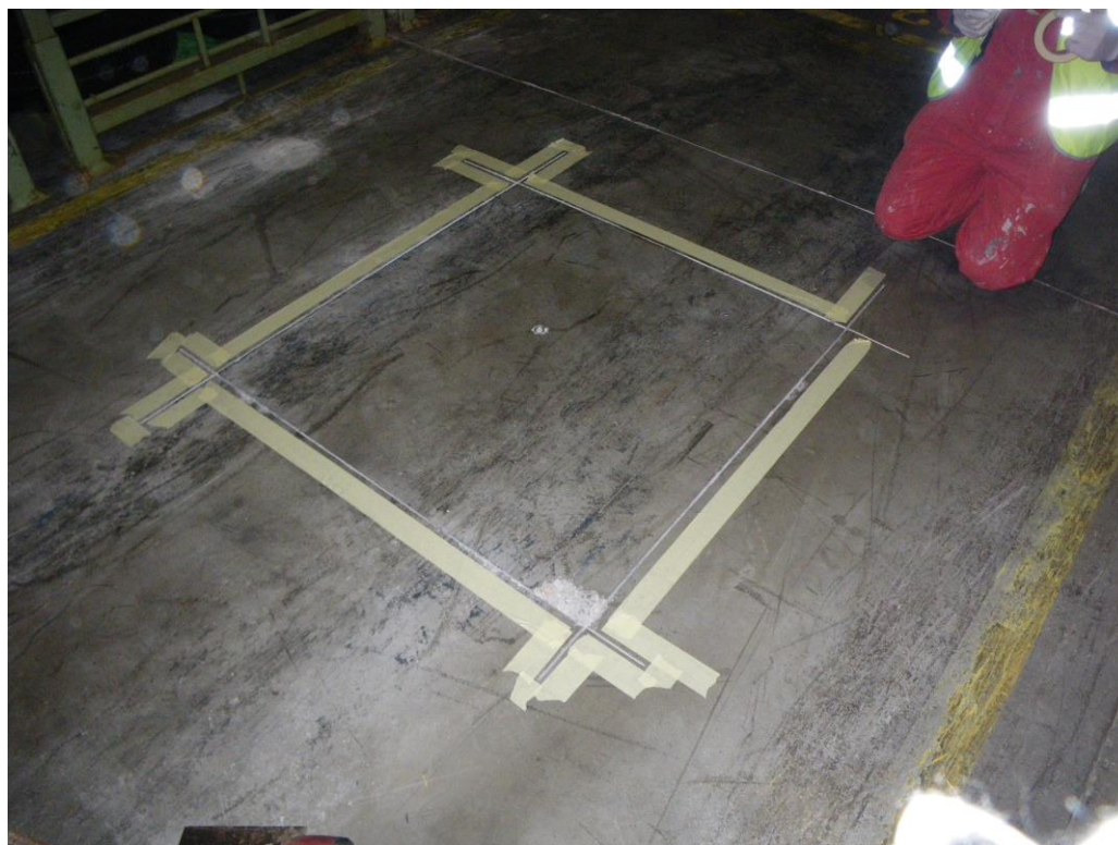
SANACIJA TLAKOV, SAVA KRANJ
