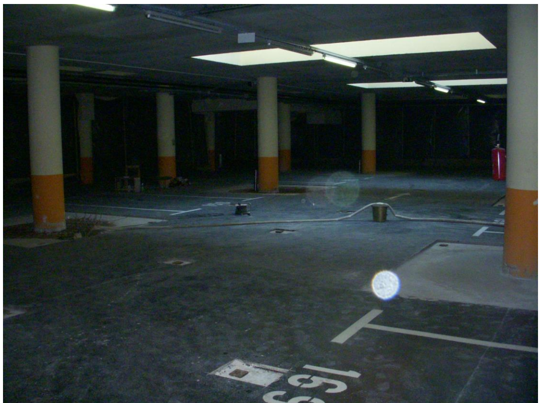
SANACIJA VDIRANJA VODE, GARAŽNA HIŠA LUCIJA
