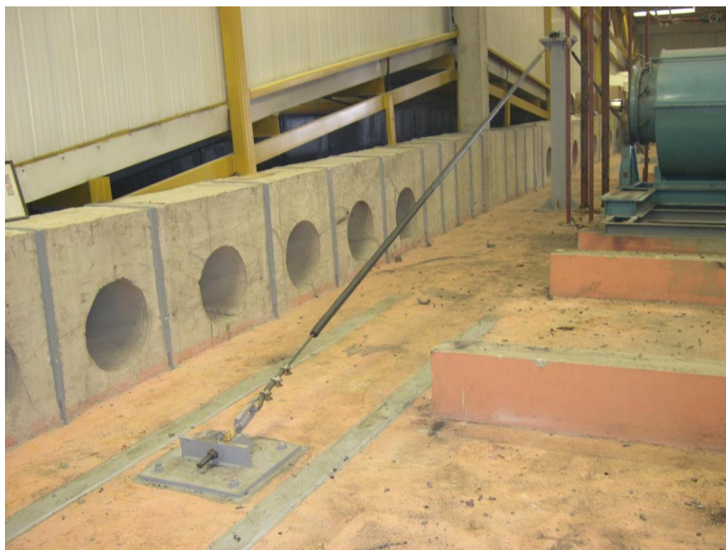
SANACIJE IN OJAČITVE RAZNIH KONSTRUKCIJ, KRKA NOVO MESTO
