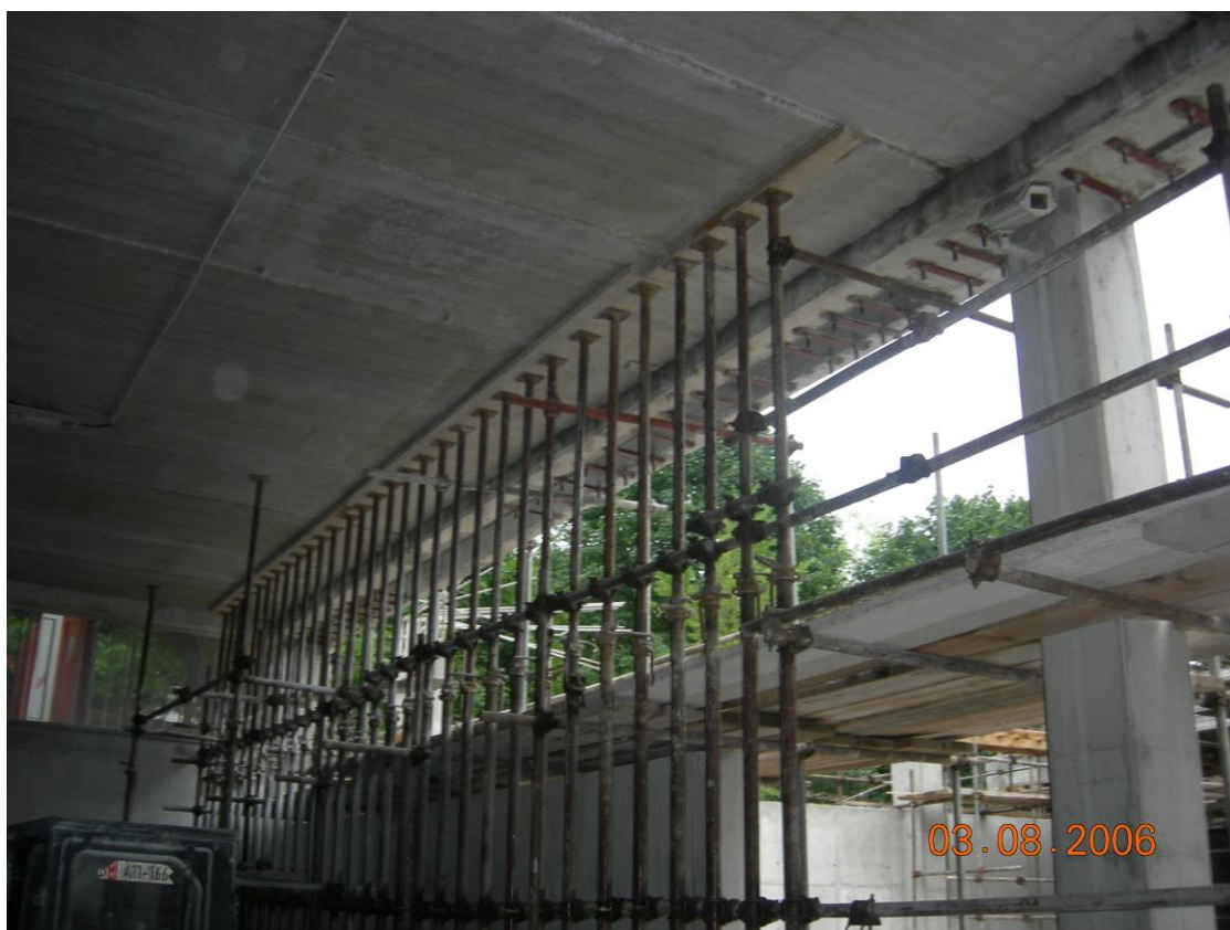
STATIČNA UTRDITEV AB NOSILCA, CALCIT d.o.o., STAHOVICA
