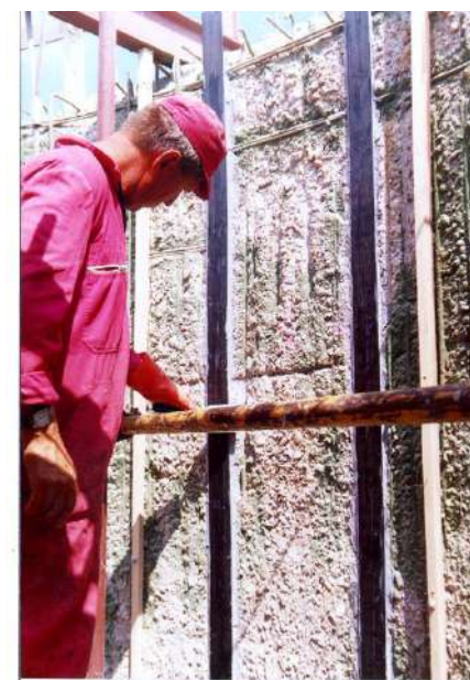
Pláš hladilnega stolpa TE Šoštanj - (prva aplikacija dolepljene kompozitne armature v Sloveniji) 1996
