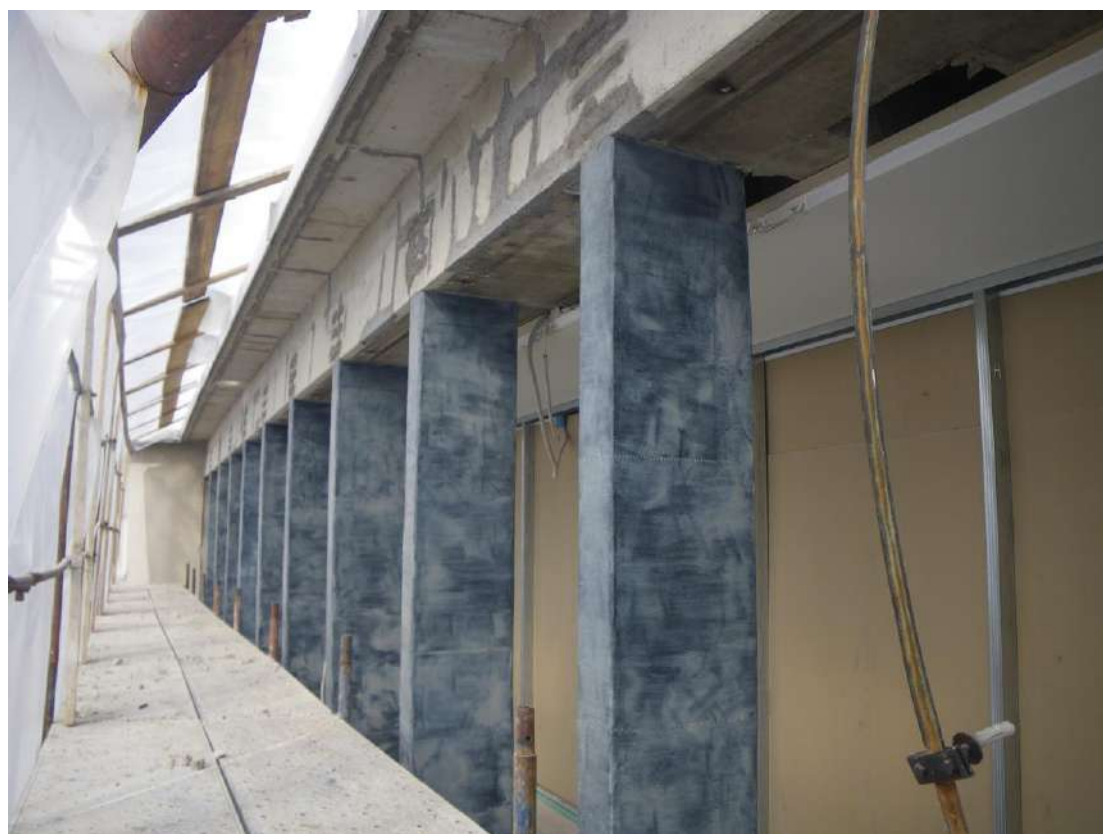
Upravna stavba SIJ, Ljubljana
