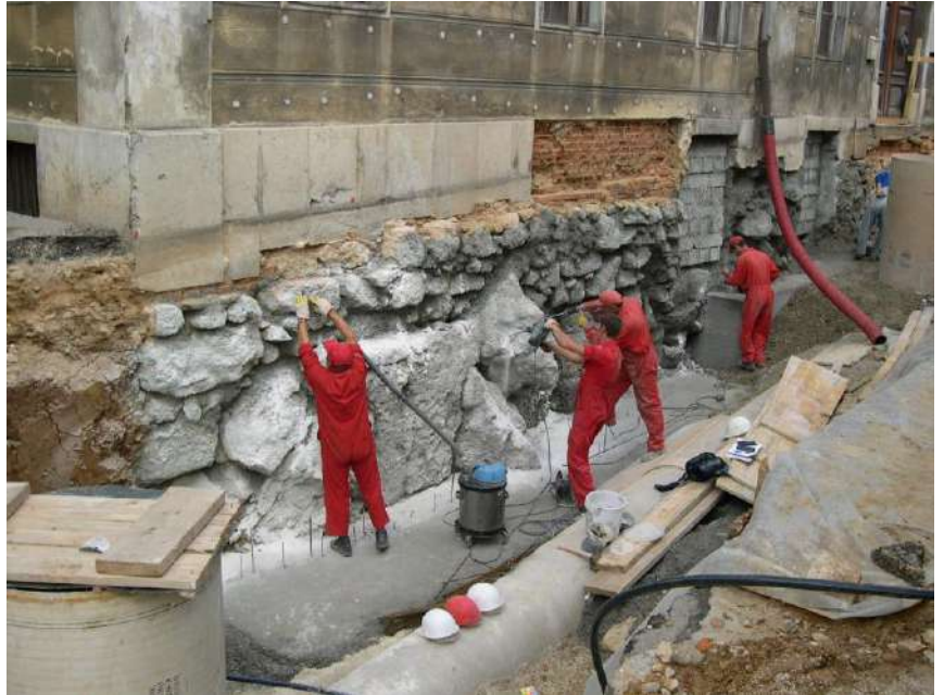
SANACIJA TEMELJEV NARODNEGA DOMA, NOVO MESTO
