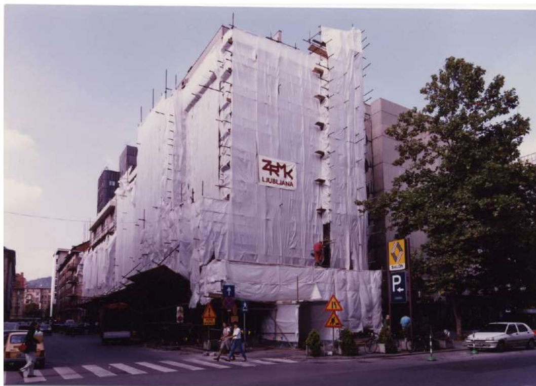
SANACIJA FASADE HOTELA AUSTROTEL, LJUBLJANA
