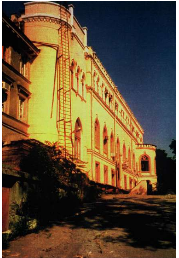
SANACIJA VLAGE V NOSILNIH ZIDOVIH, DVOREC BLASCO, UKRAJINA
