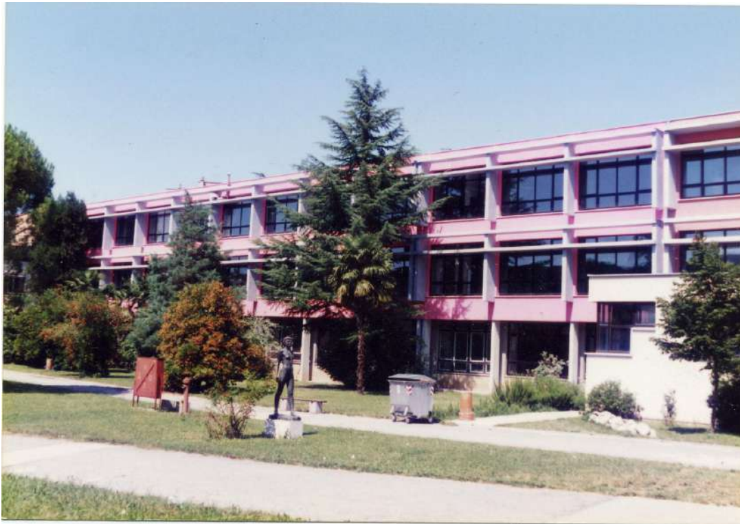
SANACIJA FASADE GIMNAZIJE, NOVA GORICA
