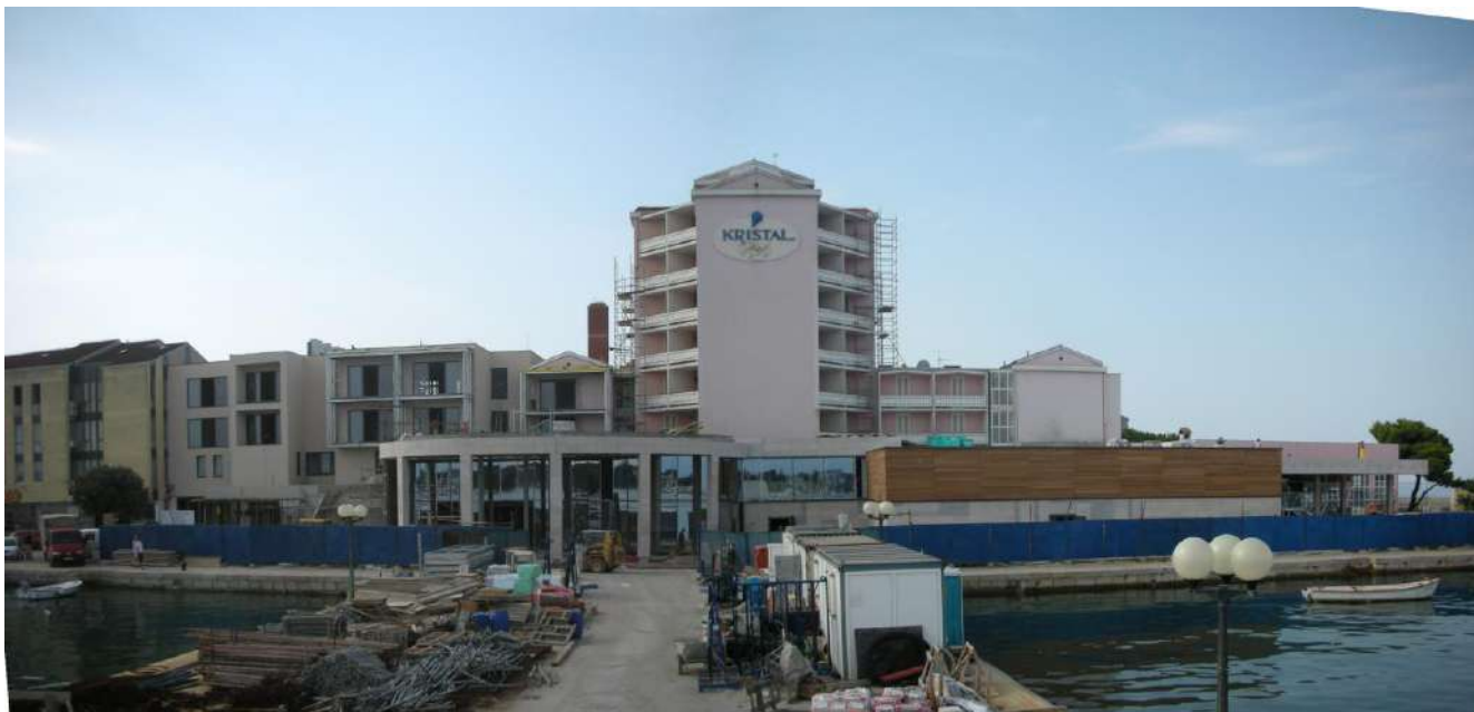
SANACIJA VLAGE V OBJEKTU HOTEL KRISTAL UMAG, HRVAŠKA
