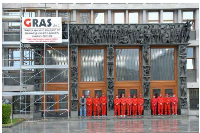
SANACIJA KAMNITE FASADE ZGRADBE DRŽAVNEGA ZBORA RS, LJUBLJANA
