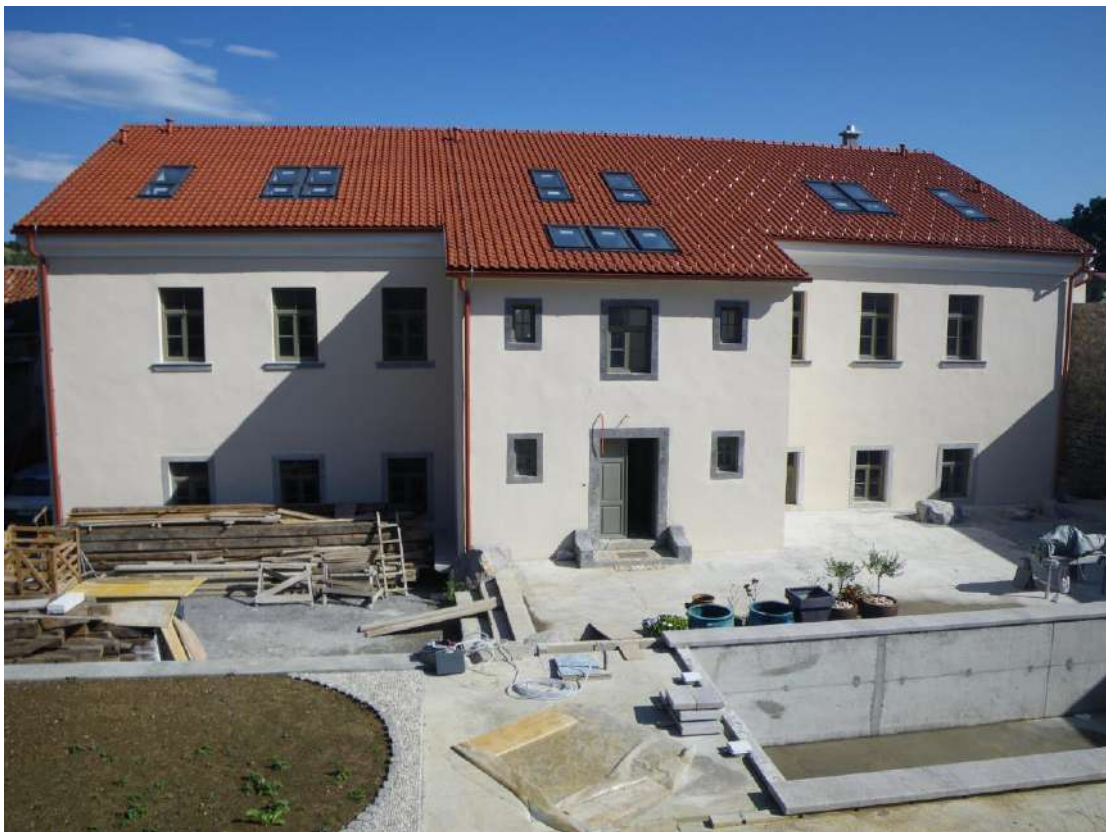
SANACIJA IN UTRDITEV »STARE ŠOLE«, SENOŽEČE
