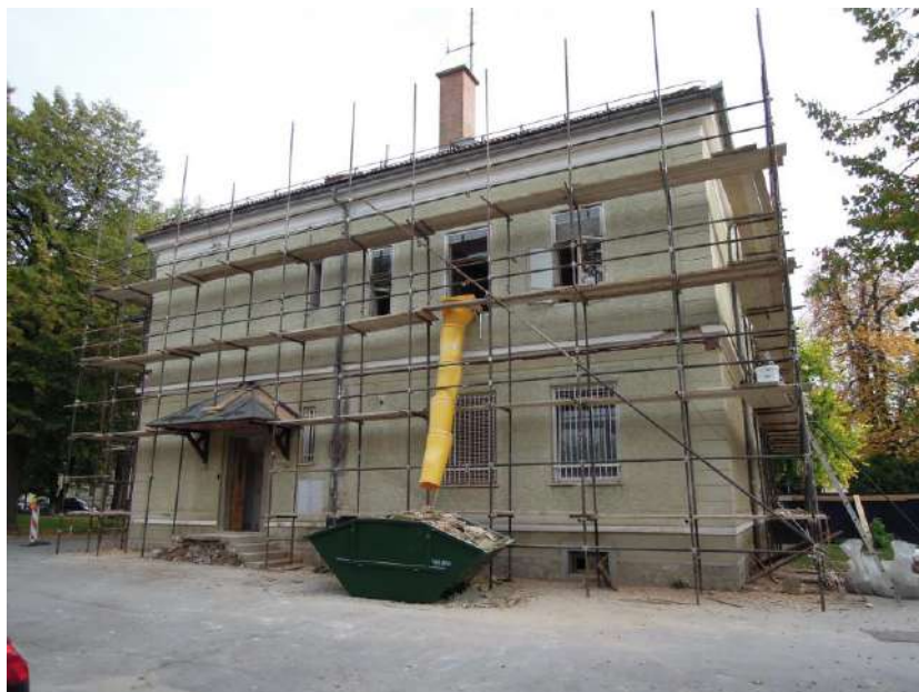
SANACIJA VLAGE IN STATIČNA UTRDITEV, BIVŠA STAVBA POLICIJE, KOČEVJE
