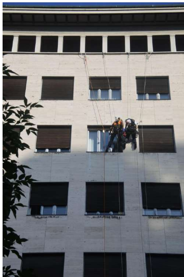
POPRAVILO FASADE, MNZ LJUBLJANA
