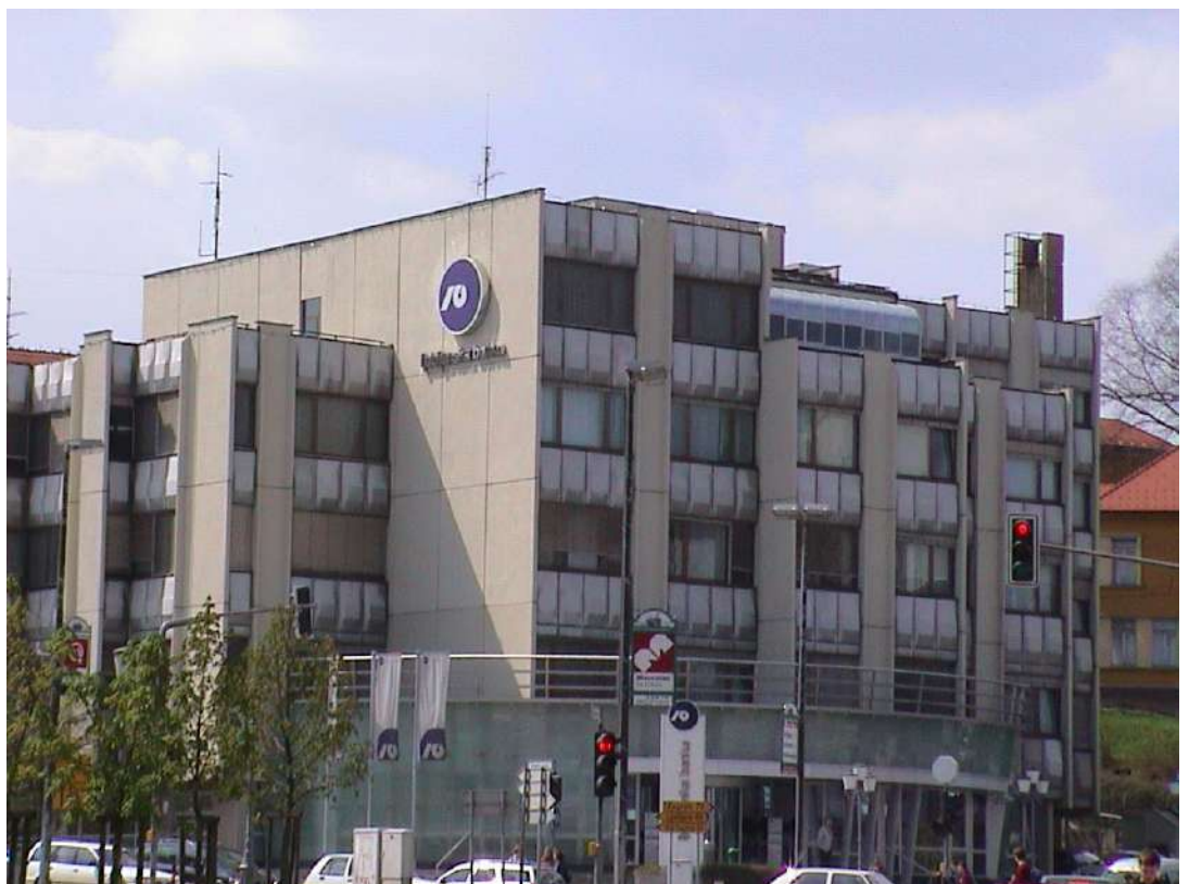
SANACIJA FASADE NLB, NOVO MESTO
