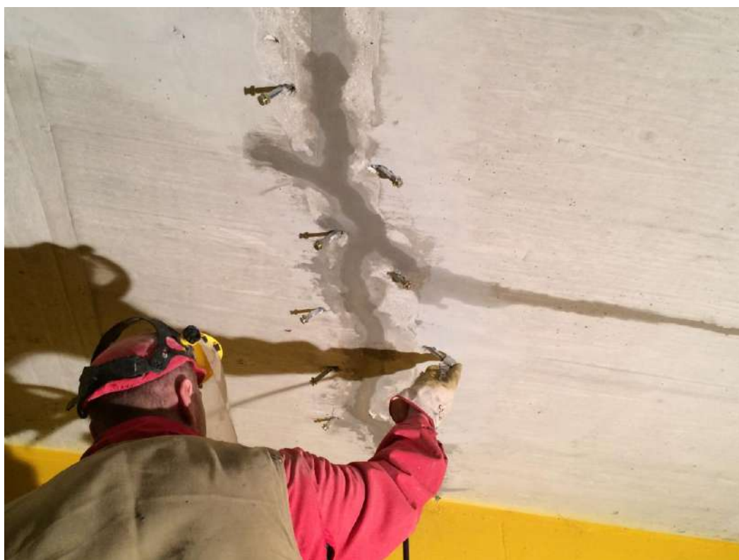
SANACIJA ZAMAKANJA V KLETI POSLOVNEGA OBJEKTA BRDO, LJUBLJANA
