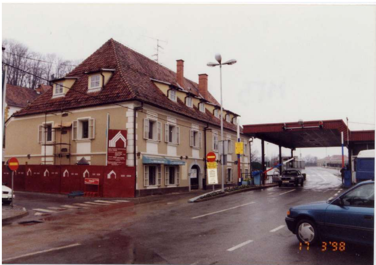
UTRDITEV ZIDOV IN SANACIJA VLAGE, MEJNI PREHOD GORNJA RADGONA
