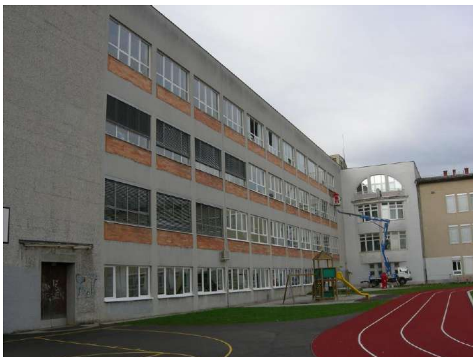
SANACIJA FASADE, GIMNAZIJA ŠIŠKA, LJUBLJANA
