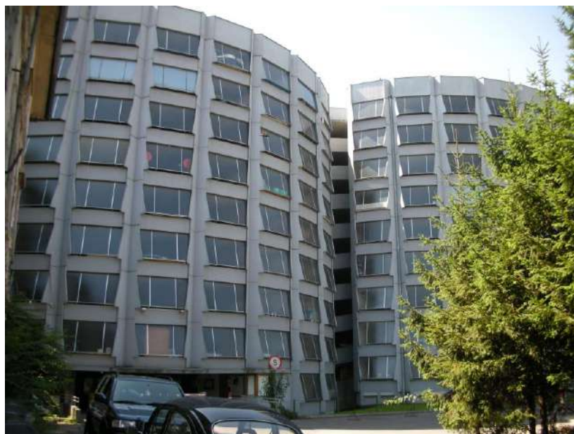
SANACIJA FASADE GARAŽE AMBROŽEV TRG, LJUBLJANA
