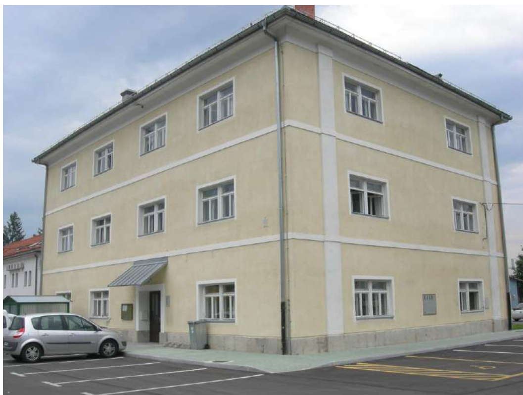
SANACIJA VLAGE V OBJEKTU GLASBENA ŠOLA, KOČEVJE
