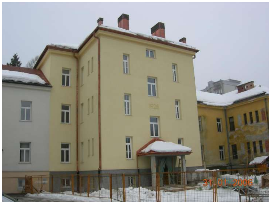
SANACIJA BIVŠE VOJAŠNICE, ŠKOFJA LOKA
